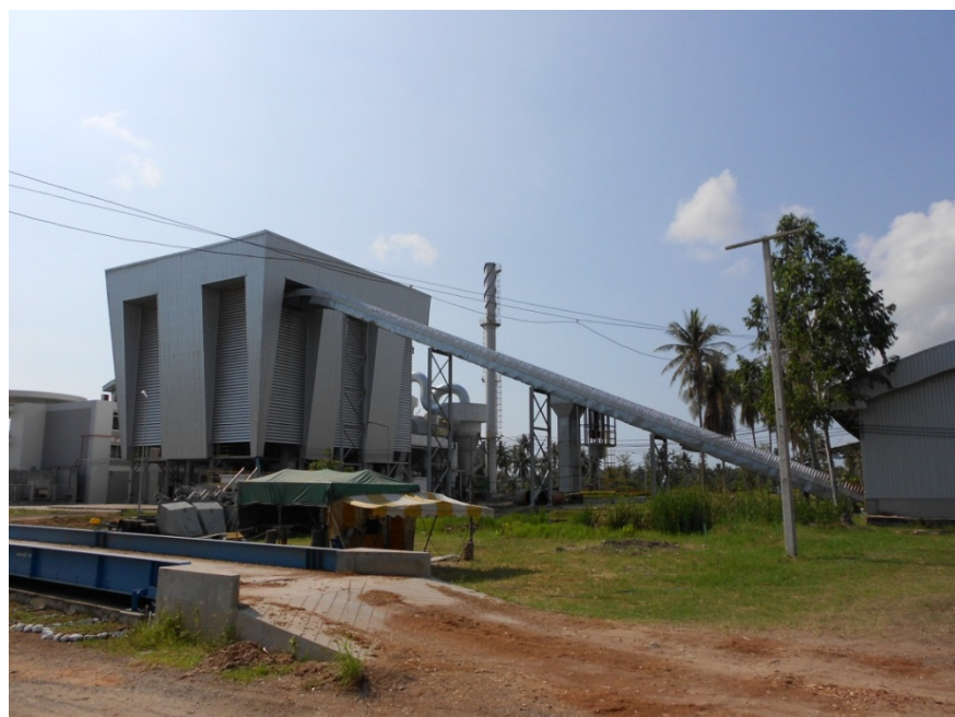
รูปที่ ค-6 โรงไฟฟ้าจากเชื้อเพลิงชีวมวลของบริษัท พลังงานสะอาดดี ทับสะแก จำกัด
