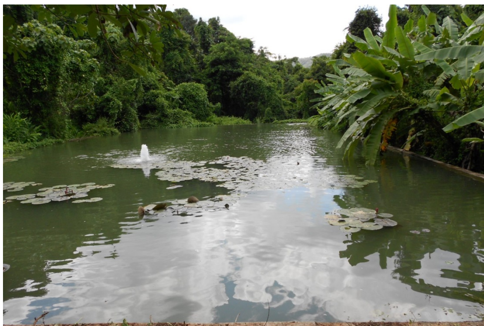
รูปที่ ค-16 โรงไฟฟ้าจากพลังน้ำขนาดเล็กห้วยคั่ง
