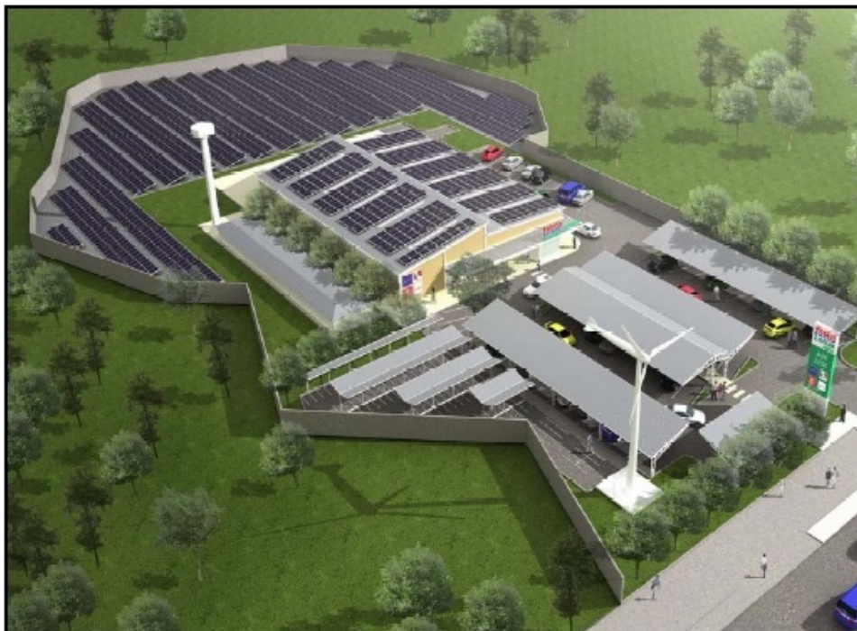
รูปที่ ค-2 Integrated solar roof top and ground mounted PV 330 kWp
