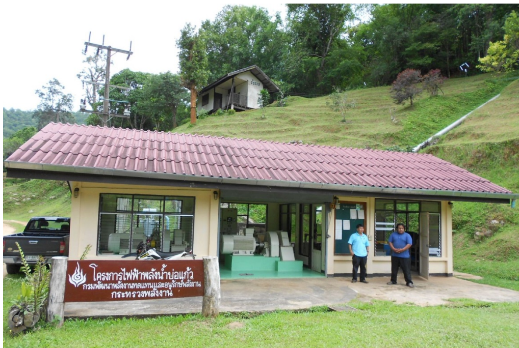
รูปที่ ค-9 โรงไฟฟ้าจากพลังน้ำบ่อแก้ว
