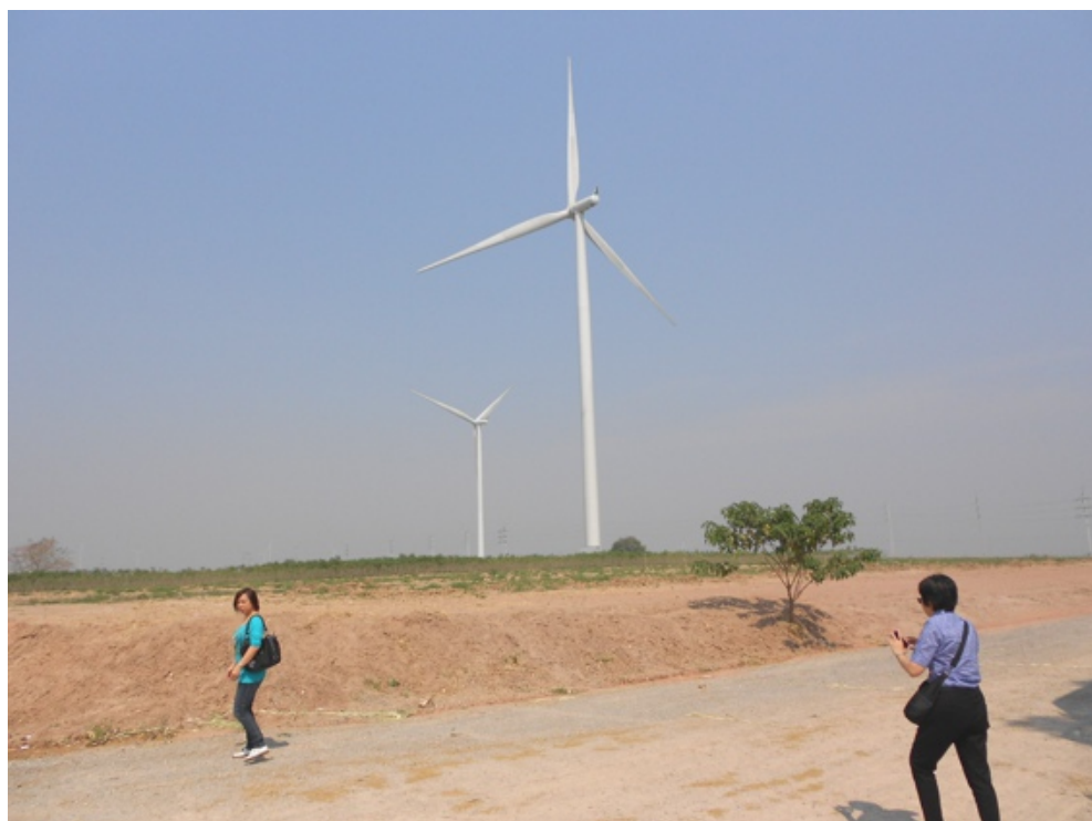
รูปที่ ค-8 โรงไฟฟ้าจากพลังงานลมของบริษัท เฟิร์ส โคราซ วินด์ จำกัด
