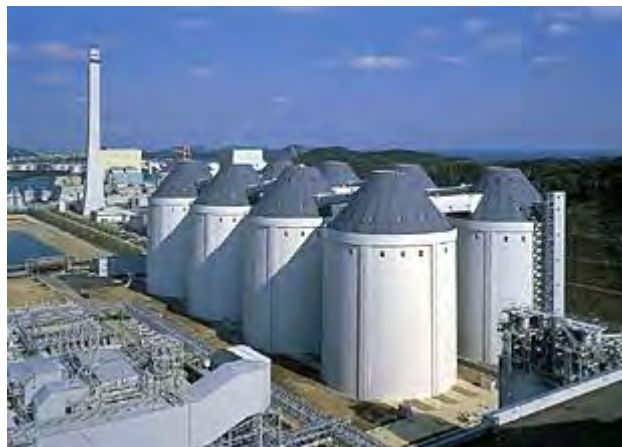
รูปที่ 2-42 การเก็บถ่านหินในประเทศญี่ปุ่นชนิดไซโล (Silo type)
