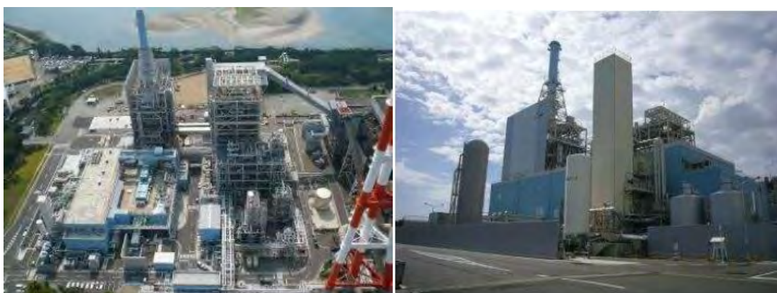
รูปที่ 2-44 แสดงภาพถ่ายโรงไฟฟ้า 250 เมกกะวัตต์ (MW) Nakoso IGCC ประเทศญี่ปุ่น
