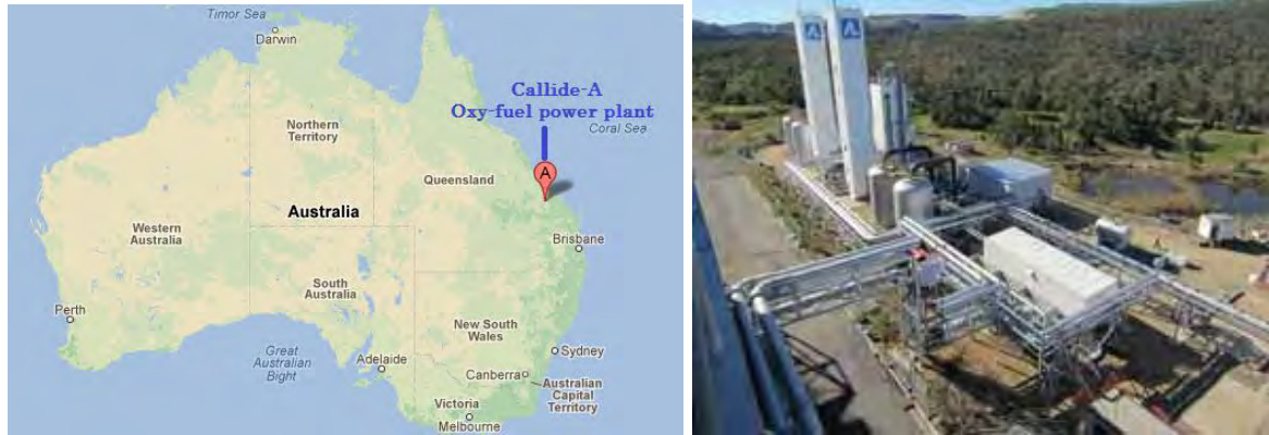
รูปที่ 2-48 แสดงที่ตั้งและภาพถ่ายโรงไฟฟ้า Callide-A Oxy-fuel 30 เมกกะวัตต์ (MW) ประเทศออสเตรเลีย [2-27]
