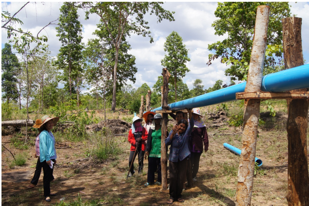
ภาพที่ 4.16 การทำสะพานเชื่อมวางท่อ
