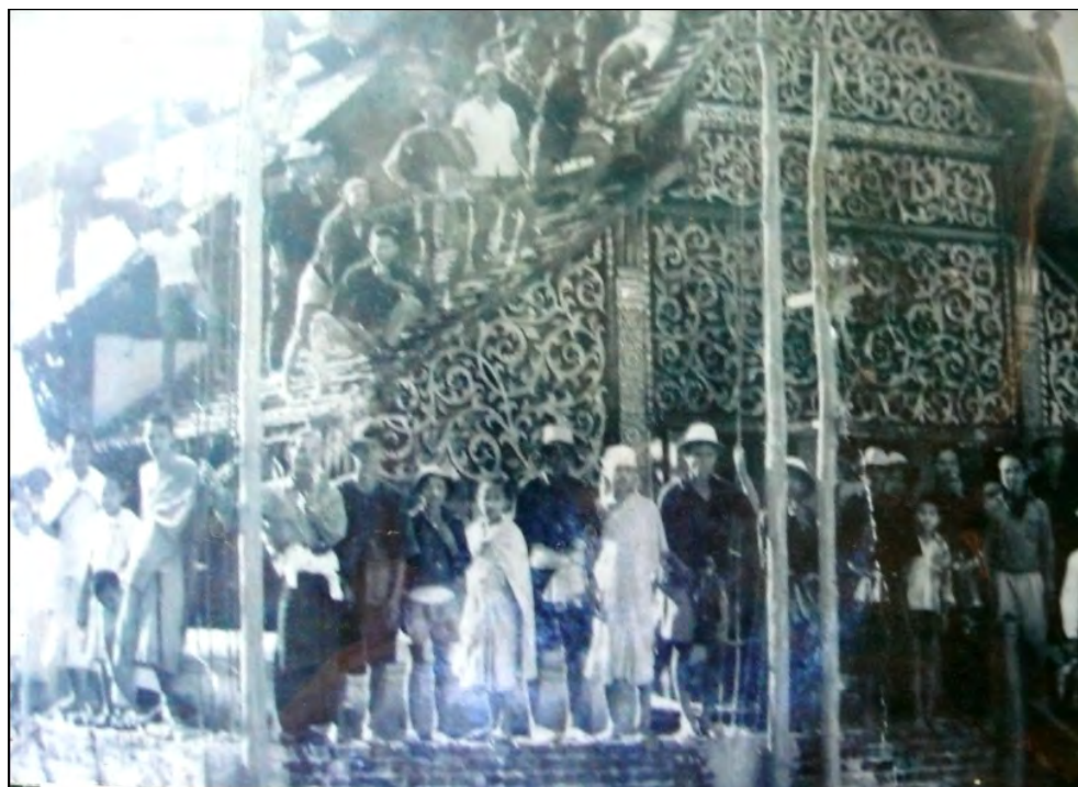
ภาพที่ 5.26 ภาพถ่ายเก่าเมื่อคราวบูรณะโบสถ์หลังใหม่
