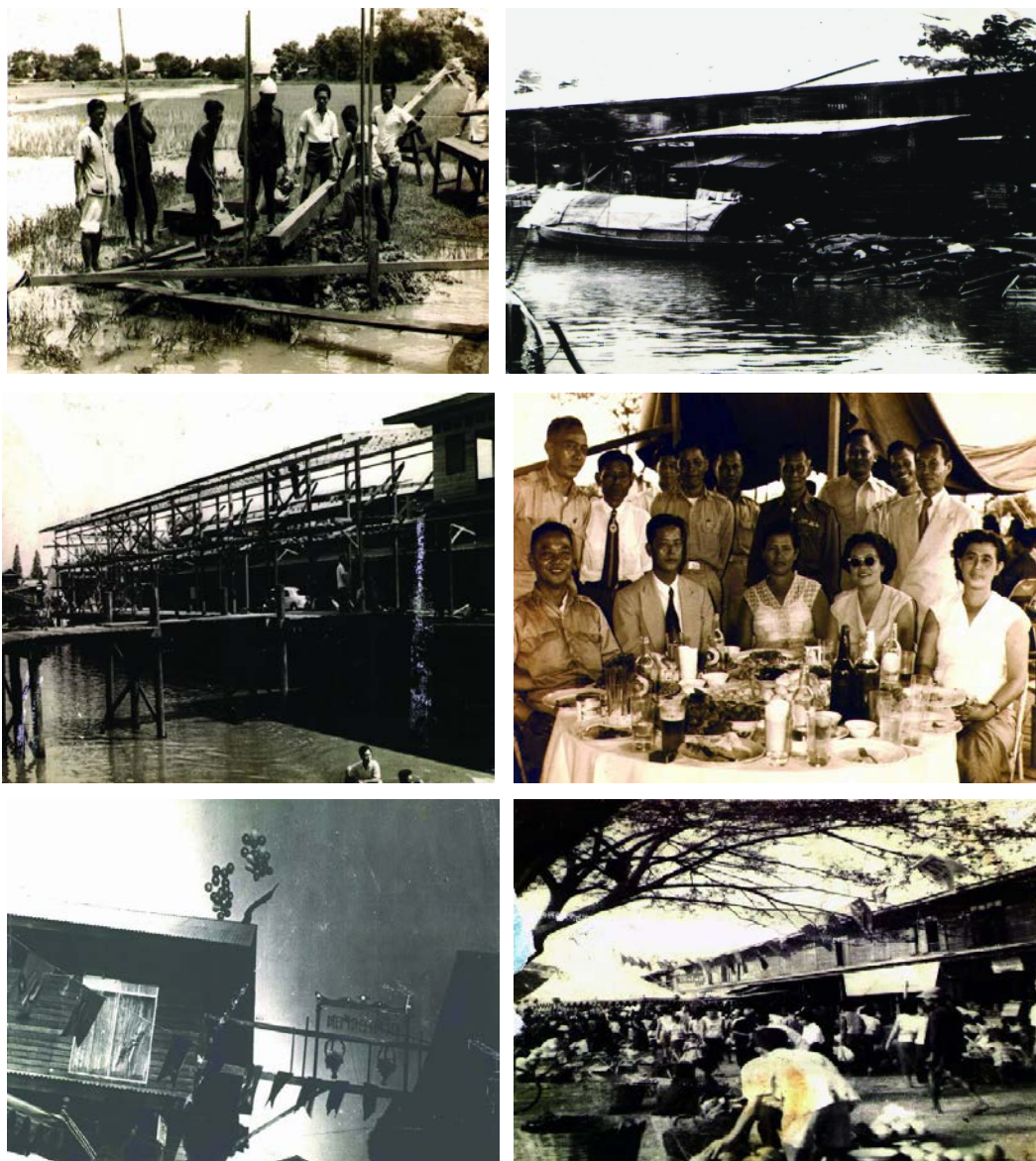
รูปภาพที่ 4.15 การก่อสร้างตลาดยี่งอหรือตลาดสะพานใหม่และภาพตลาดในปัจจุบัน
