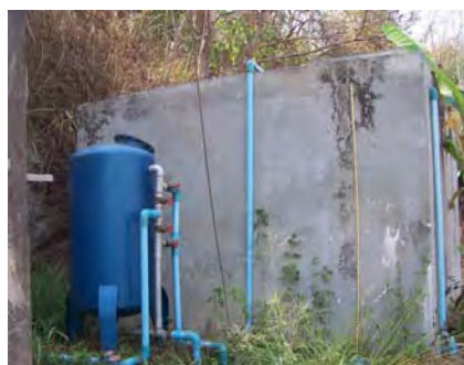
รูปที่ 56 ที่พักน้ำ
