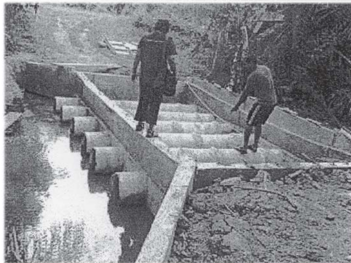
รูปแบบฝายน้ำล้น ได้รับงบจาก อบจ.สงขลา ในหมู่ 7
