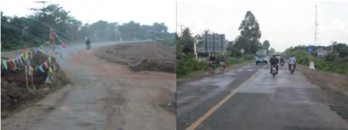
ภาพที่ 4-19 สภาพเส้นทางหมายเลข 5 เข้าสู่กรุงเทพมหานคร บางส่วนกำลังซ่อมแซม (ที่มา: จากการสำรวจภาคสนาม (2556))
