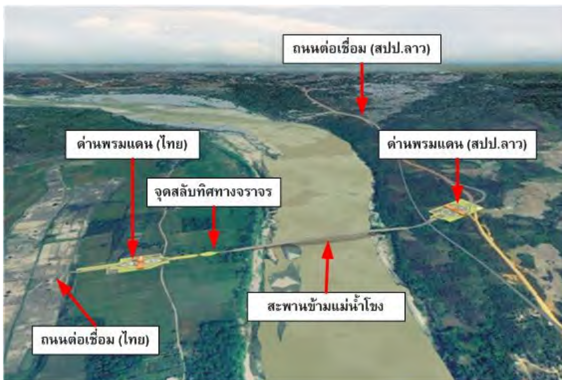
ภาพที่ 4-70 โครงการก่อสร้างสะพานมิตรภาพไทย-ลาวแห่งที่ 4 (ที่มา: กรมทางหลวง (2555))
