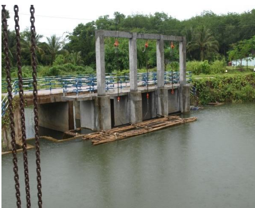
ประตูระบายน้ำแบบเปิด ปิด บริเวณ หมู่ที่ 7 บ้านเหนือคลอง ตำบลช้างซ้าย
