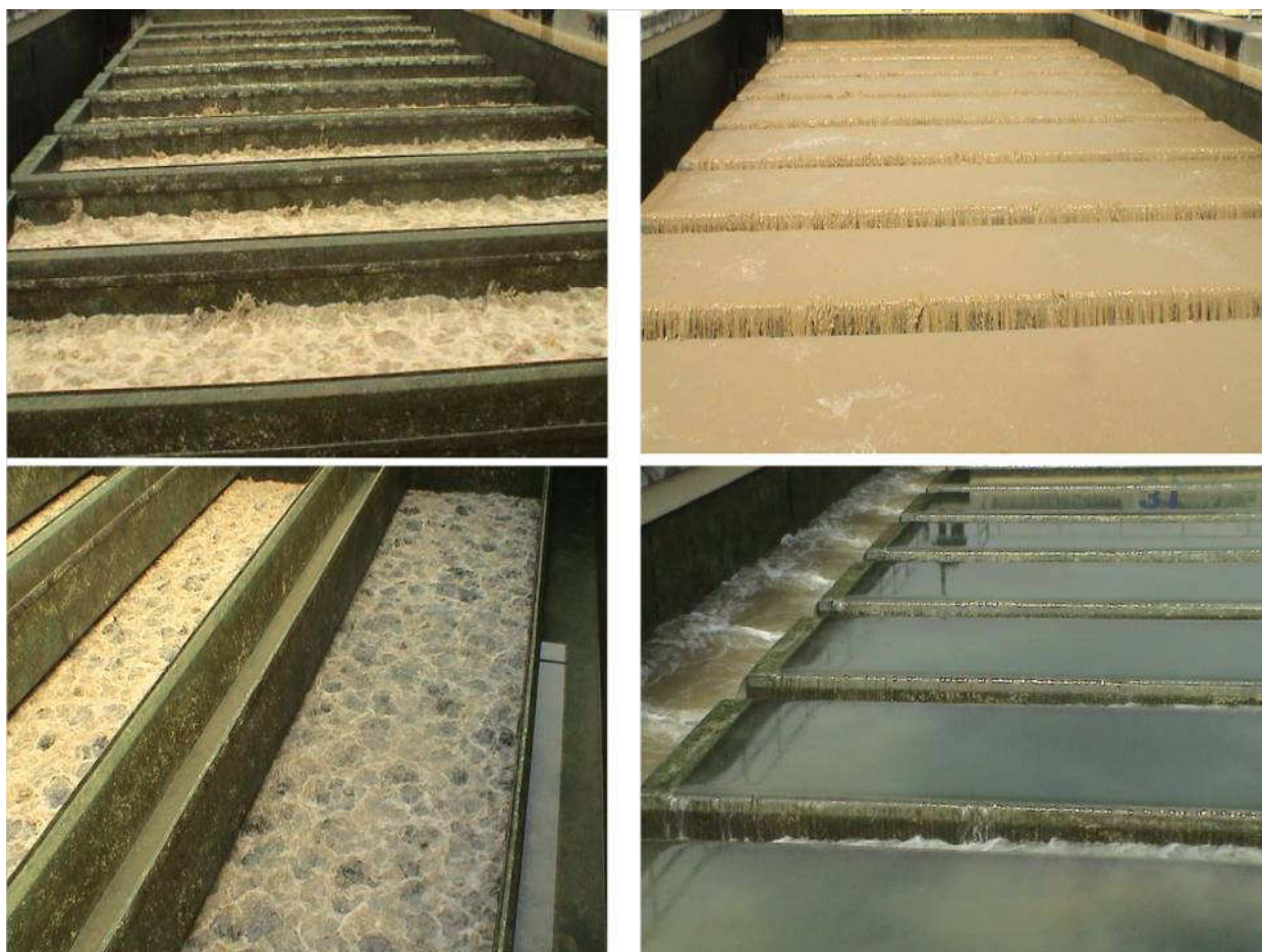
ภาพที่ 3.17 การล้างระบบกรองของโรงงานผลิตน้ำบางเขน
