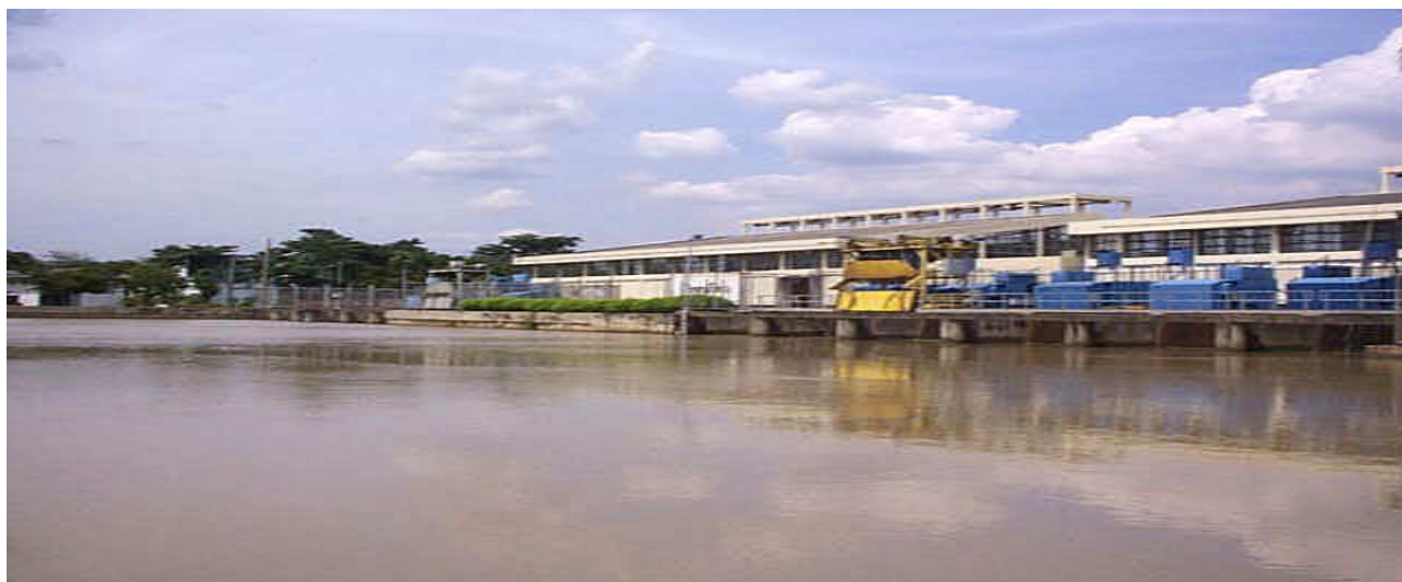
ภาพที่ 3.8 โรงสูบน้ำดิบในโรงงานผลิตน้ำบางเขน
