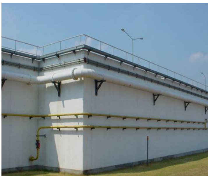
ภาพที่ 3.19 ถังน้ำใสทำหน้าที่เป็นคลังเก็บน้ำประปาที่ผ่านการทำลายจุลินทรีย์ก่อโรคแล้ว
