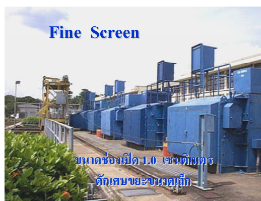
ภาพที่ 3.9 ระบบอุปกรณ์การกำจัดเศษสิ่งสกปรกที่มองเห็นได้ด้วยตาเปล่าที่ปนเปื้อนในน้ำดิบ
