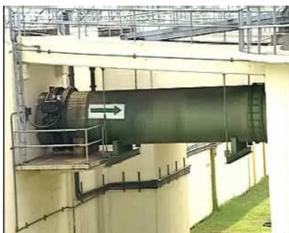
ภาพที่ 3.12 ภาพระบบท่อที่ช่วยให้เกิดการปั่นป่วนก่อนเข้าสู่ถังตกตะกอน
