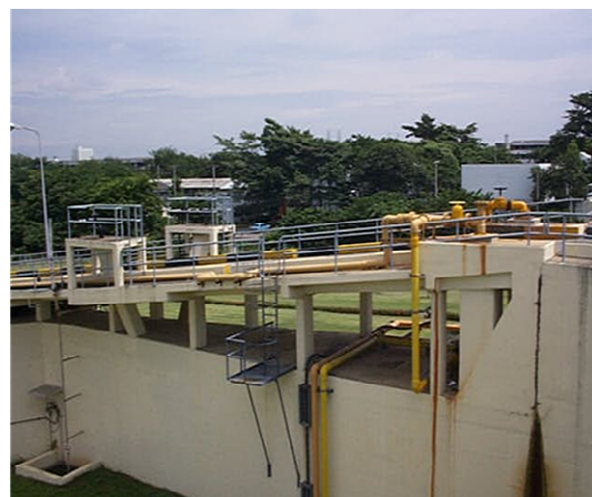
ภาพที่ 3.11 จุดเติมสารเคมีเพื่อปรับปรุงคุณภาพน้ำก่อนเติมสารตกตะกอน
