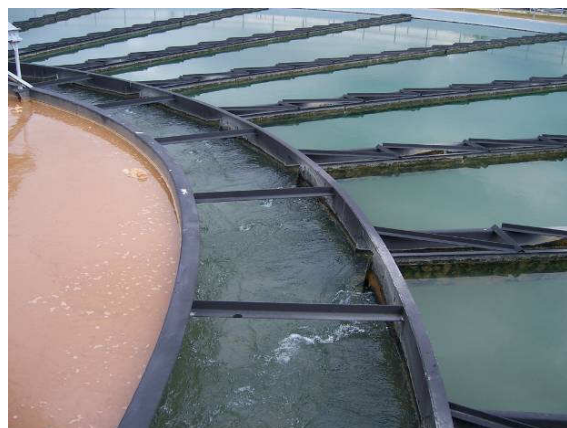
ภาพที่ 3.14 ด้านนอกของถังตกตะกอนซึ่งเป็นพื้นที่การปล่อยให้ตะกอนจมลง และลำเลียงน้ำใสออกไป
