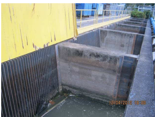
ภาพที่ 3.9 ระบบอุปกรณ์การกำจัดเศษสิ่งสกปรกที่มองเห็นได้ด้วยตาเปล่าที่ปนเปื้อนในน้ำดิบ
