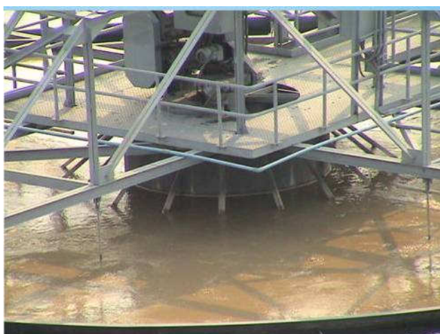
ภาพที่ 3.13 ด้านในของถังตกตะกอนซึ่งเป็นการกวนช้าเพื่อให้ตะกอนมีขนาดใหญ่ขึ้น
