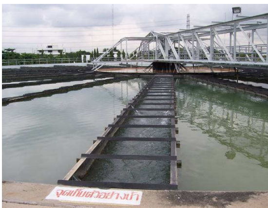
ภาพที่ 3.14 ด้านนอกของถังตกตะกอนซึ่งเป็นพื้นที่การปล่อยให้ตะกอนจมลง และลำเลียงน้ำใสออกไป
