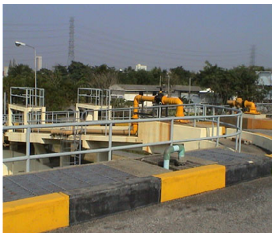
ภาพที่ 3.11 จุดเติมสารเคมีเพื่อปรับปรุงคุณภาพน้ำก่อนเติมสารตกตะกอน
