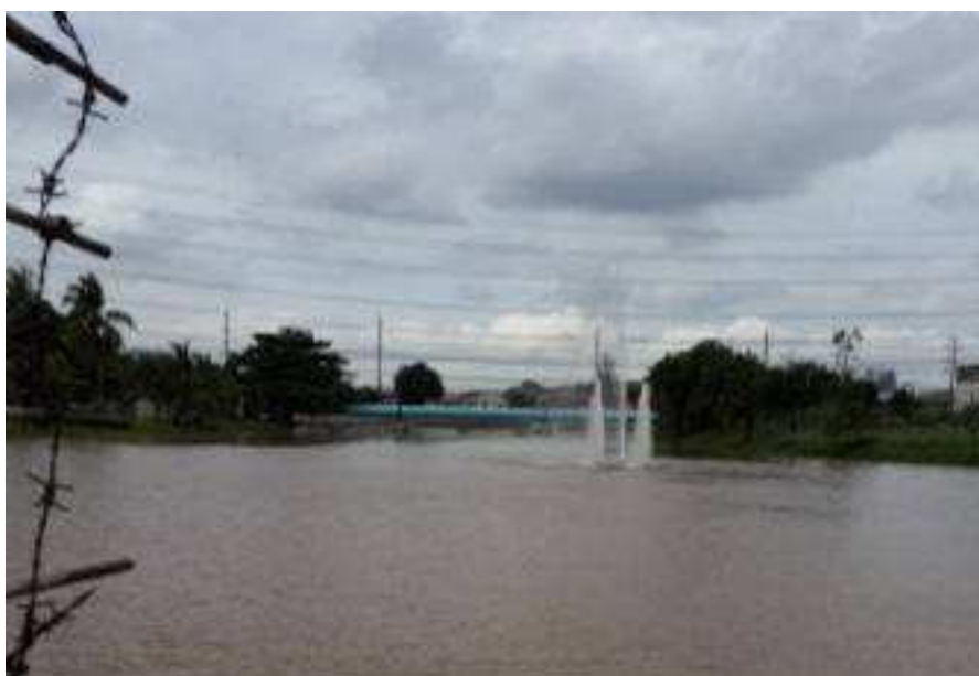
ภาพที่ 3.6 แหล่งกักเก็บน้ำดิบก่อนสูบน้ำผ่านเข้าสู่โรงสูบน้ำดิบ ณ โรงงานผลิตน้ำบางเขน
