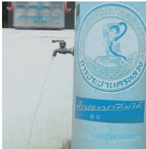
ภาพที่ 2.3 การปล่อยน้ำค้างเส้นท่อ
