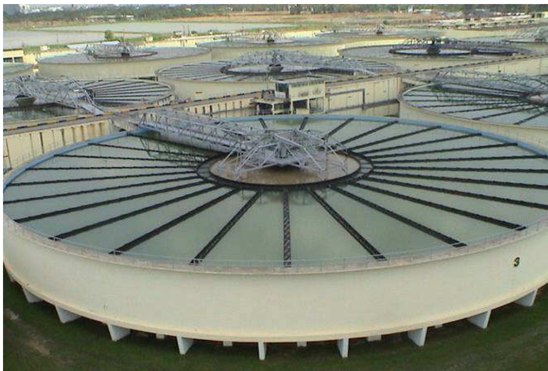
ภาพที่ 3.10 ถังตกตะกอนขนาดเส้นผ่านศูนย์กลาง 58 เมตร จำนวน 18 ถัง โรงผลิตน้ำประปาบางเขน ตารางที่ 3.3 ประสิทธิภาพทางเทคนิคของถังตกตะกอน
