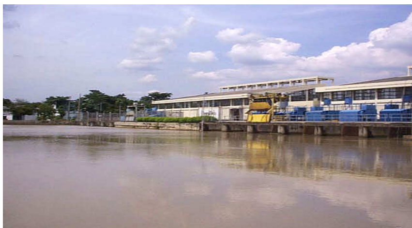
ภาพที่ 3.3 สถานีสูบน้ำดิบสำแล
