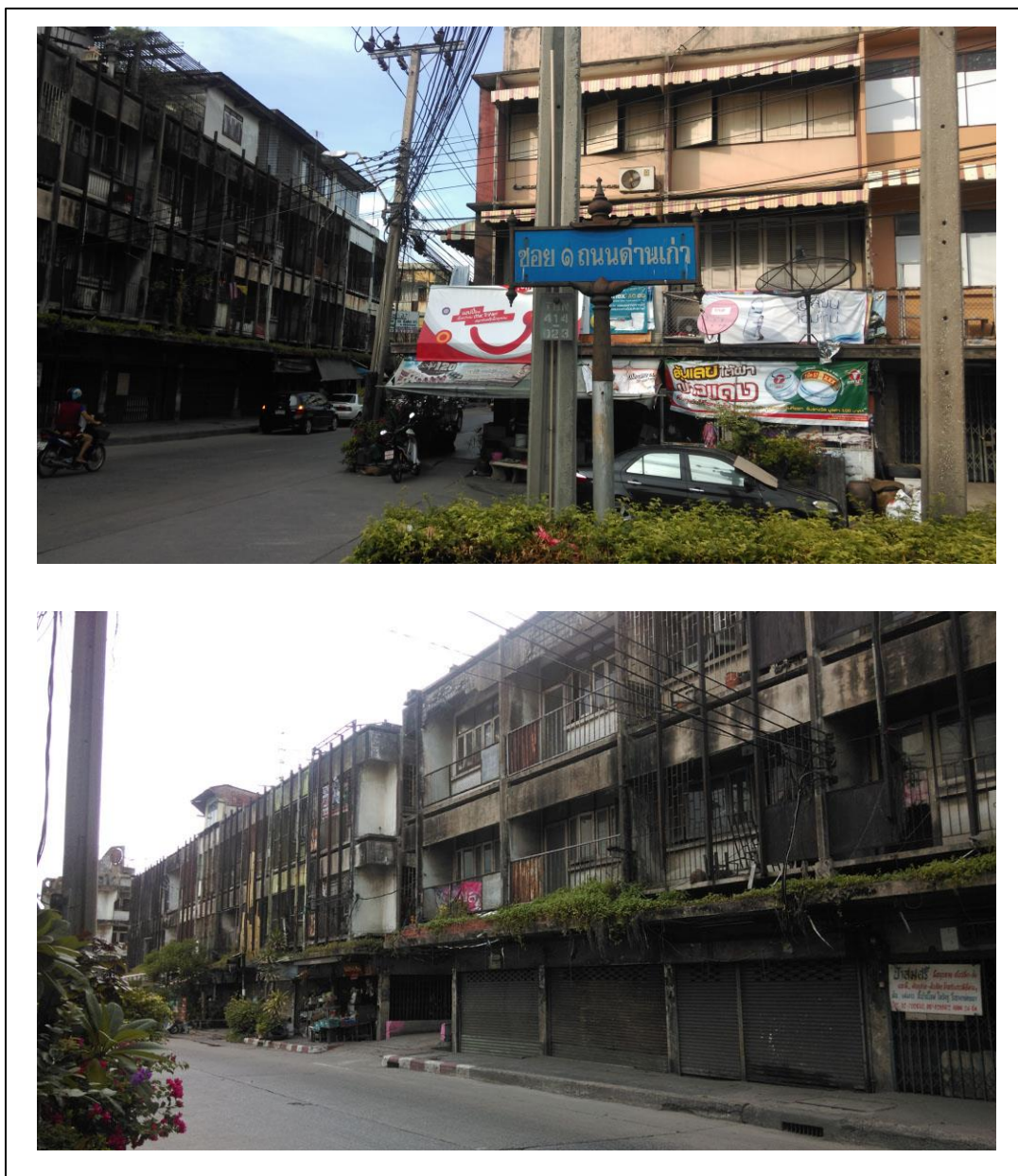
รูปที่ 6.4 อาคารพาณิชย์กรรมเสื่อมโทรมและทิ้งร้างบริเวณถนนด่านเก่า
