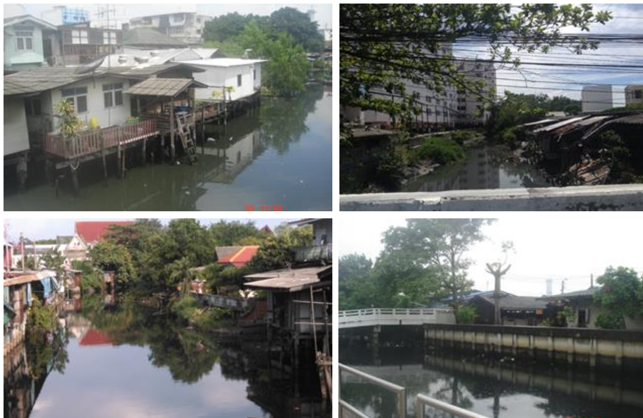
รูปที่ 6.13 อาคารชั้นเดียวบริเวณริมคลองในเขตเทศบาลนครสมุทรปราการ
