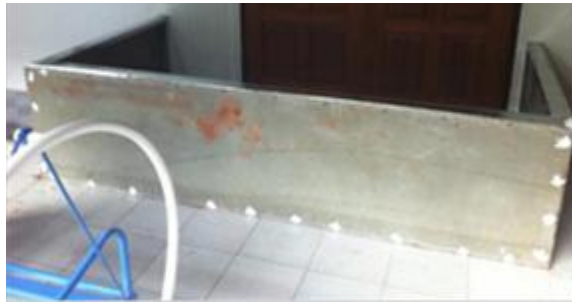
รูปที่ 2-4 กำแพงกันน้ำจากแผ่นสเมิร์ทบอร์ดขึ้นโครงด้วยเหล็กพับ ที่มา: วสท., 2557
