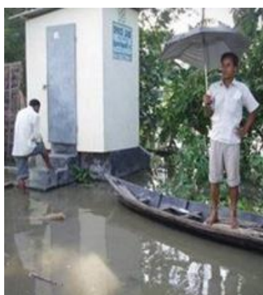
รูปที่ 2-10 ส้วมสร้างเองจากวัสดุที่มีขายในท้องถิ่น
