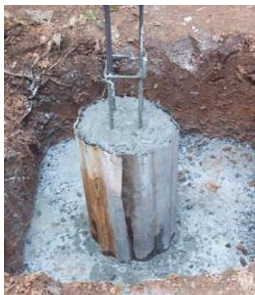
รูปที่ 8-28 การใช้บัพสังกะสีเป็นแบบหล่อคอนกรีต
