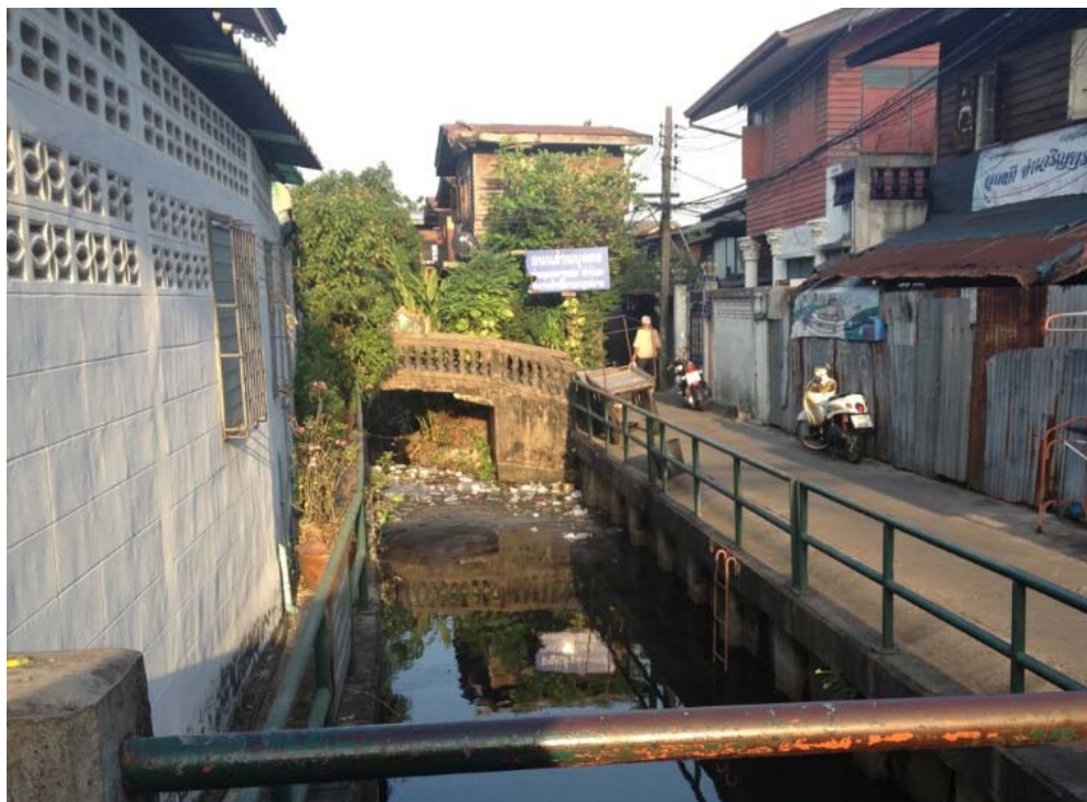
ภาพที่ 5.25 สภาพคลองย่อยที่กลายเป็นที่ทิ้งขยะและสภาพที่มีคนคอนกรีตขวาง
