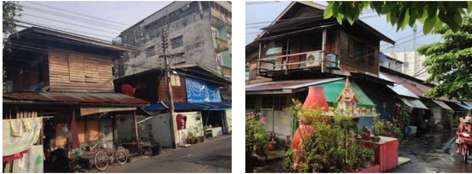
ภาพที่ 4.41 บ้านพักอาศัย 2 ชั้น คอนกรีตผสมไม้
