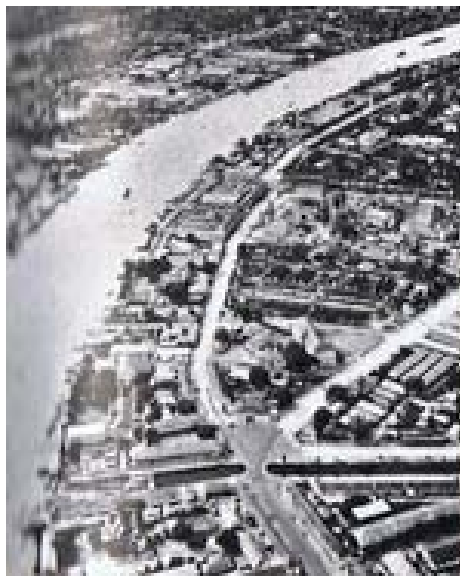
ภาพที่ 4.1 คลองลัด กลายเป็นแม่น้ำเจ้าพระยา (สายใหม่) ของกรุงเทพฯ
