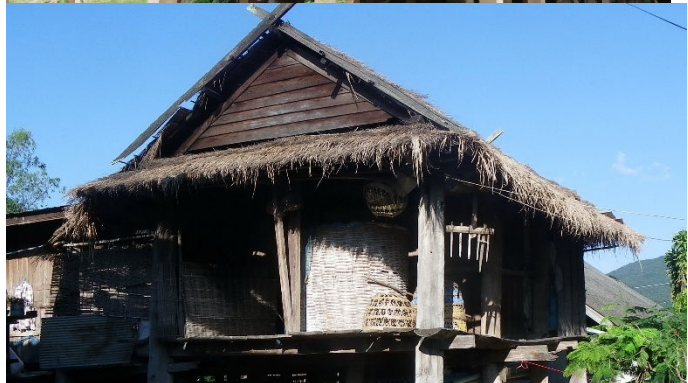
ภาพที่ 4.257 เทคนิคการก่อสร้างเฮือนไต
