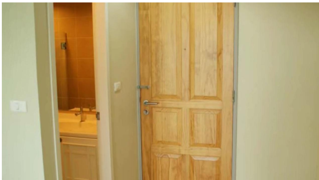
รูปที่ 4.21: กุญแจประตูห้องต้องไขง่าย
