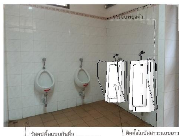
รูปที่ 6.51: สภาพก่อนและหลังการปรับปรุงสุขภัณฑ์และติดตั้งราวจับกันลื่น
