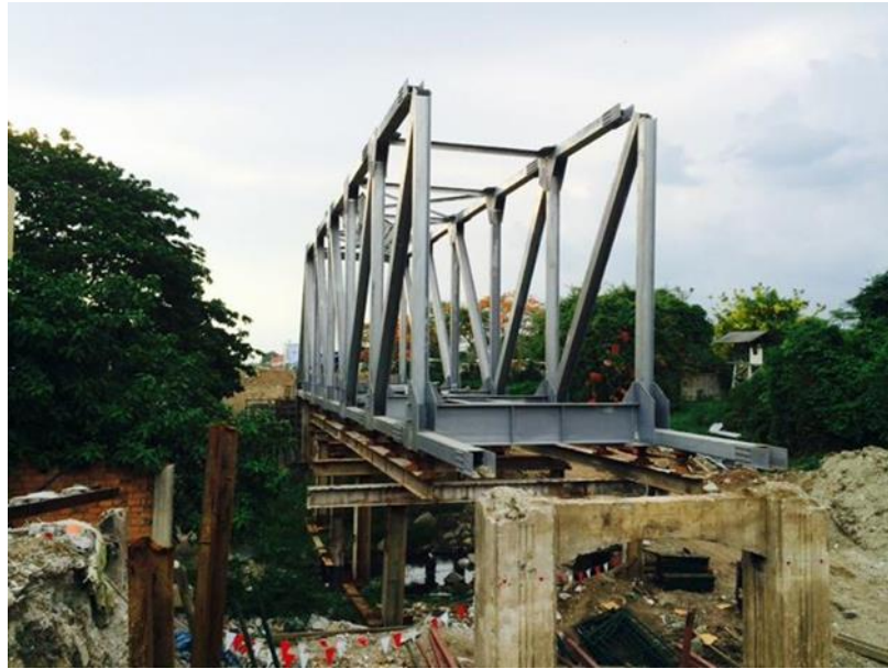
รูปที่ 4.3-4 การปรับปรุงทางและก่อสร้างสะพานรถไฟคลองลึก-ปอยเปต ข้ามลำคลองคลองลึก
