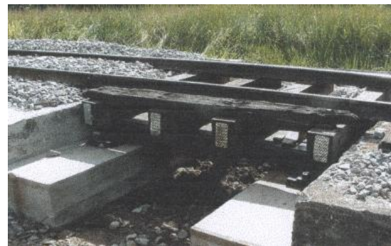
รูปที่ 3.1-14 สะพานบวราง (Rail Girder)
