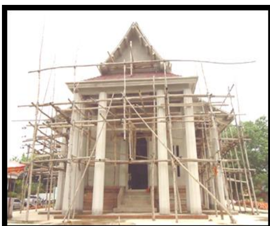
ภาพ 19 โบสถ์หลังใหม่ก่อสร้างโดยใช้เสาแปดเหลี่ยม
