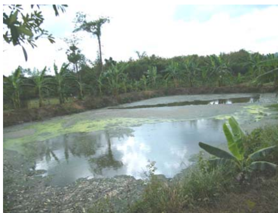
รูปที่ 4-12 บ่อปรับสภาพ (บ่อสุดท้ายของระบบบำบัด)
