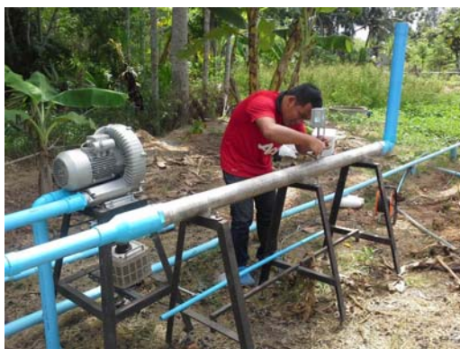
รูปที่ 4-21 การติดตั้งและตรวจวัดปริมาณก๊าซชีวภาพด้วยเครื่องวัดอัตราการไหลและอุปกรณ์ระบบท่อชุดก๊าซชีวภาพ ณ บ่อหมักก๊าซชีวภาพ สหกรณ์ฯ บ้านเก่าร้าง
