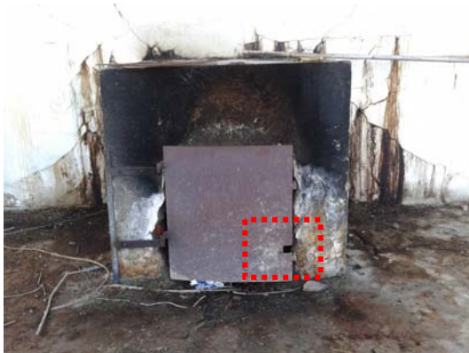
รูปที่ 4-25 ประตูเตาไม้ฟืนบริเวณที่เจาะรูสำหรับนำท่อลำเลียงก๊าซชีวภาพเข้าไปในเตาไม้ฟืน
