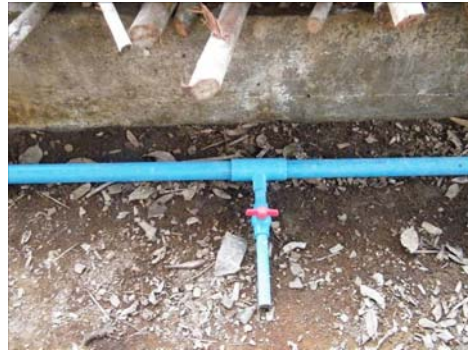
รูปที่ 4-27 วาล์วควบคุมการนำก๊าซชีวภาพเข้าเตาหมัก
