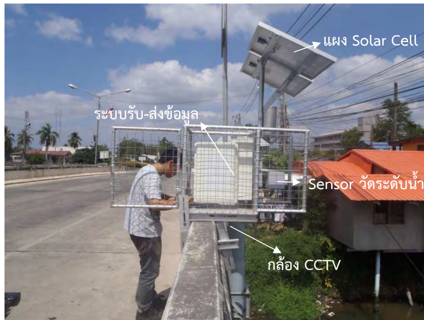
รูปที่ 4.47 ตัวอย่างสถานีโทรมาตรพร้อมอุปกรณ์ประกอบ
