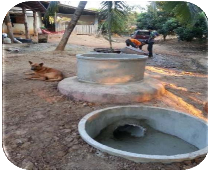
รูปที่ 32 การทำบ่อมูลลิน
