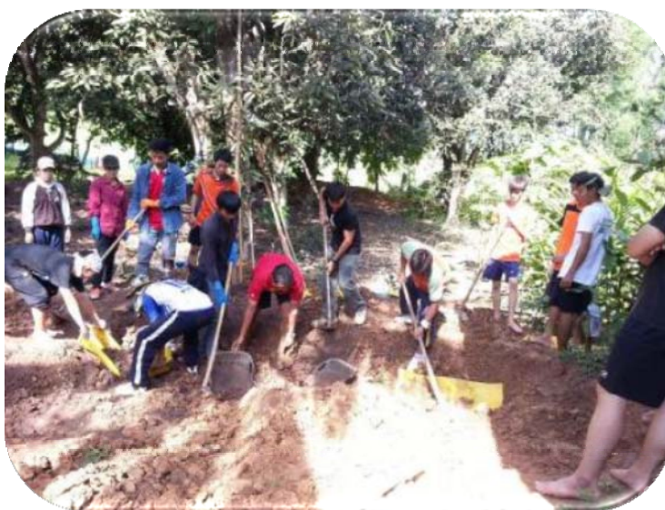
รูปที่ 29 การขุดดินเพื่อวางโ่ง
