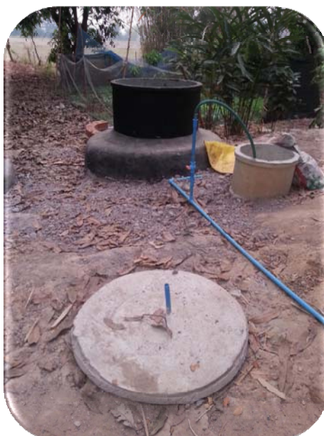
รูปที่ 36 การทำระบบรองรับก๊าซและต่อท่อเตรียมไว้สำหรับนำก๊าซไปใช้งาน
