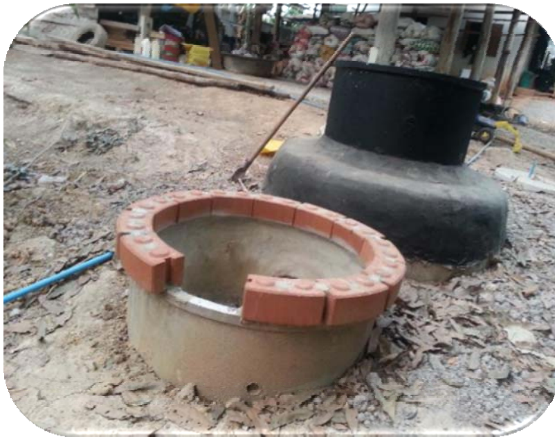
รูปที่ 35 การทาลิ้นโค้ทและตรวจเช็คจนมั่นใจได้ว่าระบบไม่รั่ว
