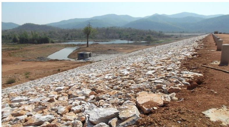
อ่างเก็บน้ำแม่รำพัน ขณะก่อสร้าง
