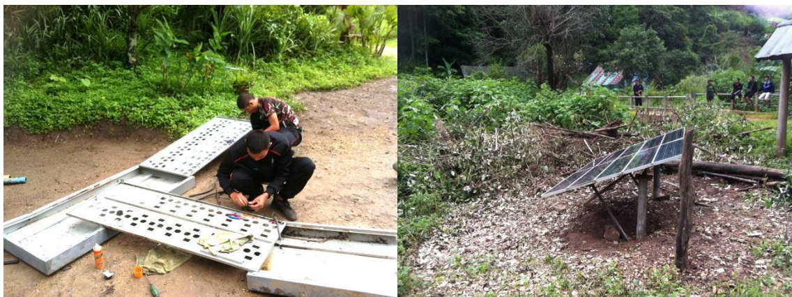
ภาพ 4-6 การปรับปรุงซ่อมแซมแผงโซลาร์เซลล์เก่าเพื่อนำกลับมาใช้งานผลิตกระแสไฟฟ้า
