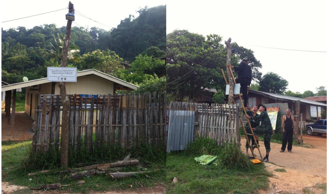
ภาพ 4-7 การติดตั้งโคมไฟ LED บริเวณถนนสาธารณะของหมู่บ้าน
