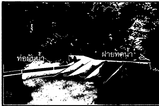
รูปที่ 2-3 ลักษณะฝายและท่อผันน้ำจากฝาย
