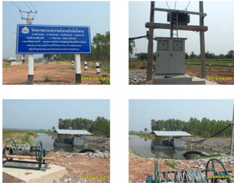
สำรวจระบบกระจายน้ำอ่างเก็บน้ำพาน
