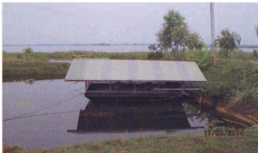
ภาพที่ 53 :เครื่องสูบน้ำประปาตำบลสร้างคอม
