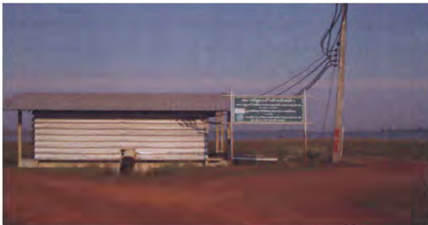
ภาพที่ 40: เครื่องสูบน้ำพลังงานไฟฟ้า
