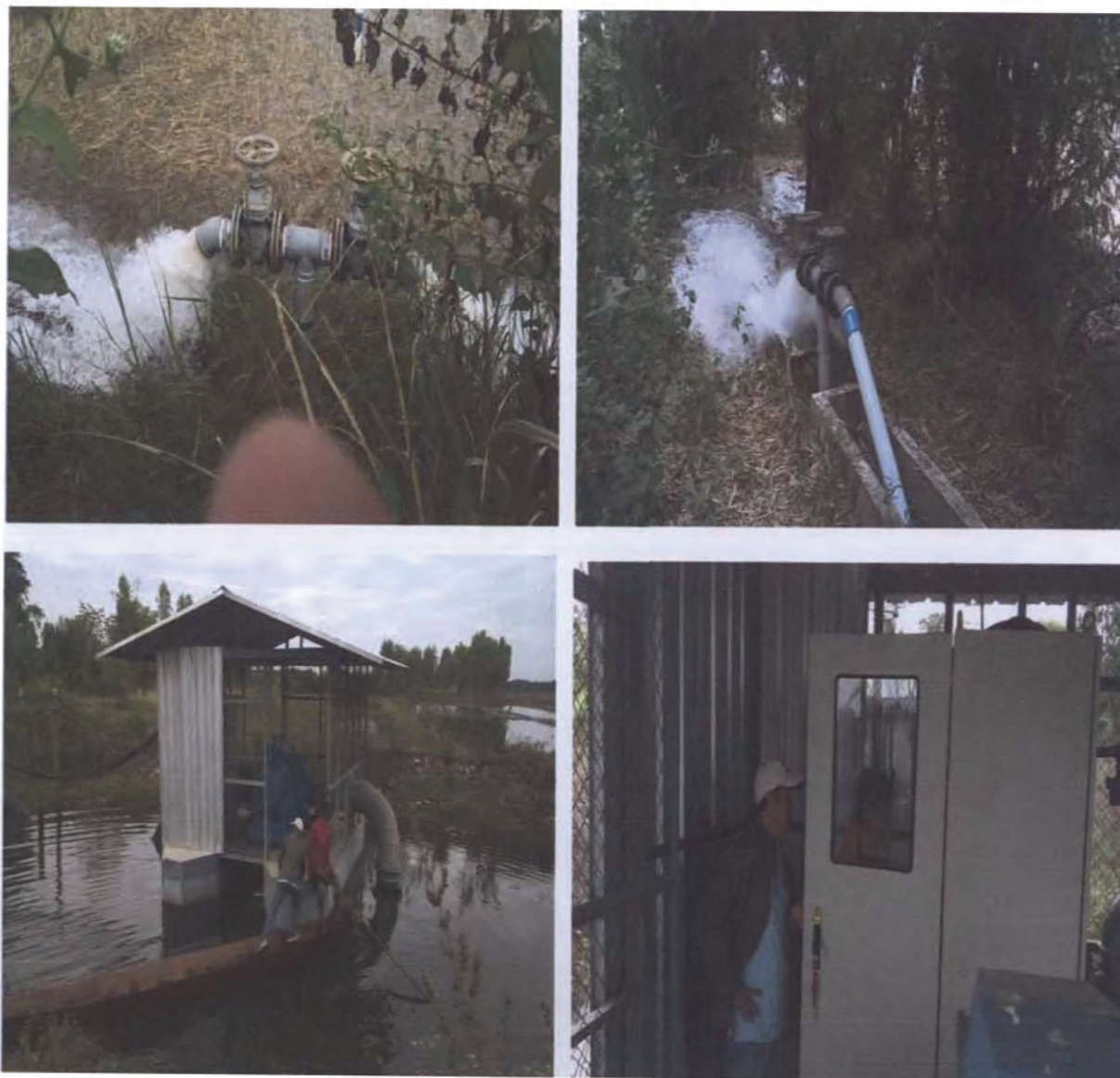
รูปที่ 23 : วันที่ 3 ธันวาคม 2557 ผู้มีส่วนได้เสีย 3 ฝ่าย ทดลองสูบน้ำด้วยเครื่องสูบน้ำพลังงานไฟฟ้า ครั้งที่ 1 เวลา 11.55 น.
