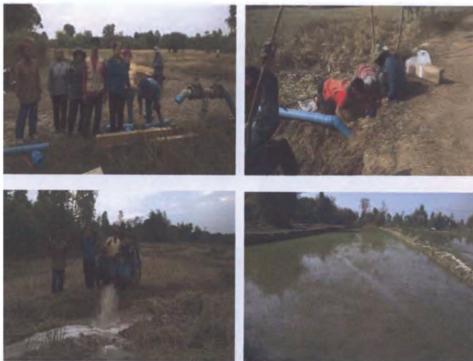
รูปที่ 13 : การดำเนินงานต่อท่อกระจายน้ำเข้าสู่แปลงนาของสมาชิกกลุ่มผู้ใช้น้ำ ระหว่างวันที่ 7 – 9 มกราคม 2558
