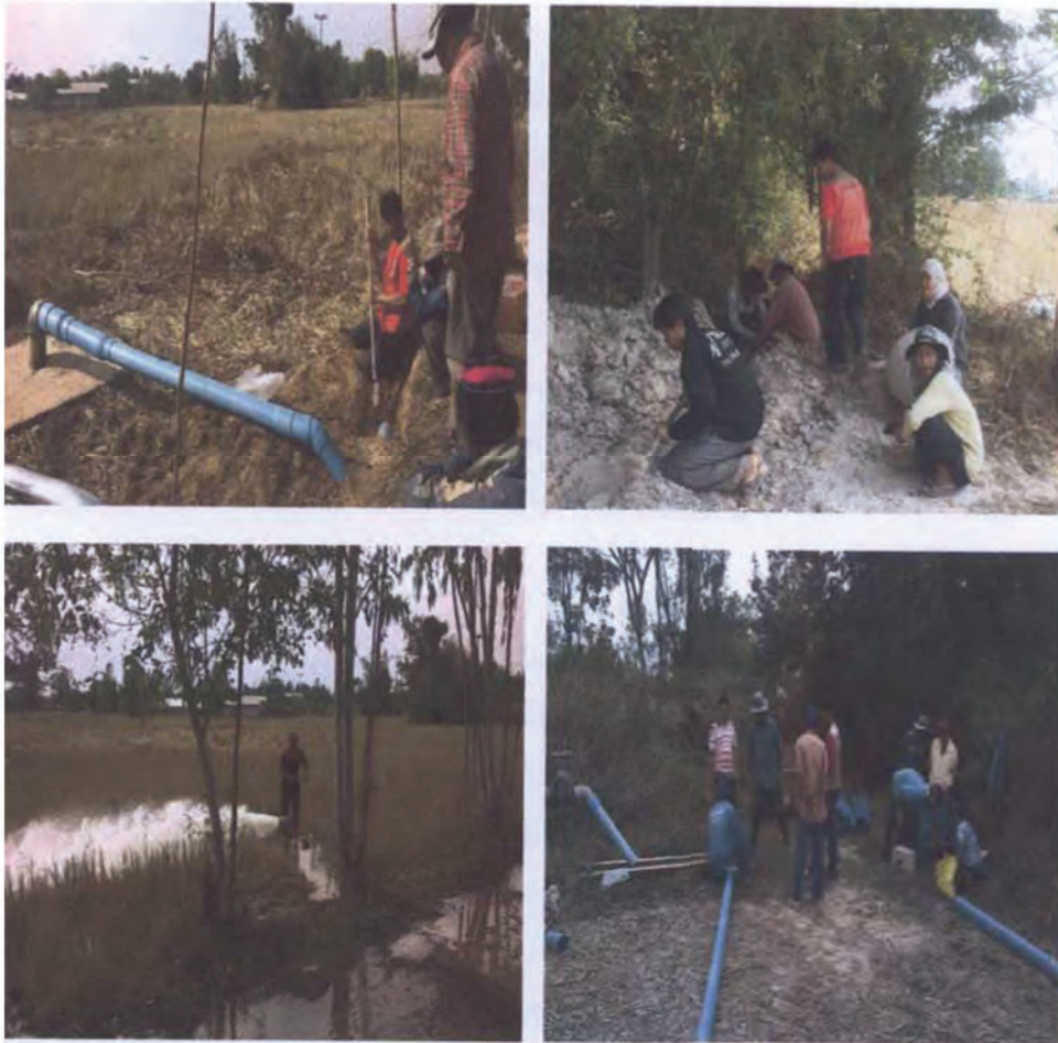
รูปที่ 52 - 55 : สมาชิกกลุ่มผู้ใช้น้ำกำลังช่วยกันวางระบบท่อกระจายน้ำเข้าสู่แปลงนา
