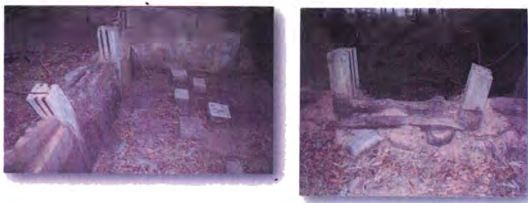
รูปที่ 2 ฝายน้ำเพื่อการเกษตรที่ชาวบ้านก่อสร้างด้วยตัวเอง
