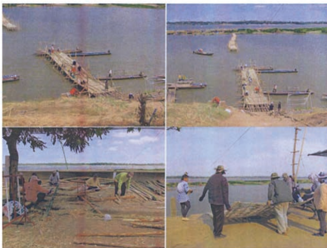
รูปที่ 5-13 ขั้นตอนการก่อสร้างสะพานไม้ไผ่
