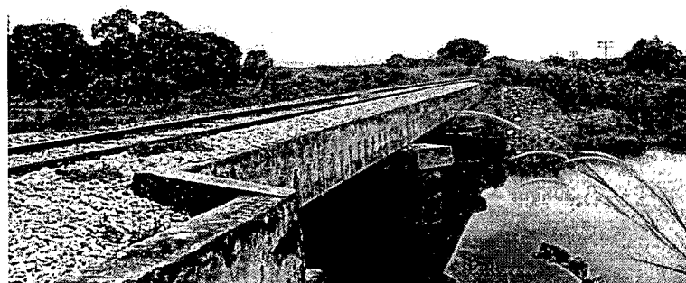
ภาพประกอบ 10 สะพานรถไฟที่สร้างขึ้นเมื่อ พ.ศ.2533
