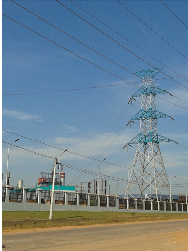
รูปที่ 2-5 โรงไฟฟ้าแห่งใหม่ในเมืองเมะล่ายที่อยู่ในระหว่างการก่อสร้าง
