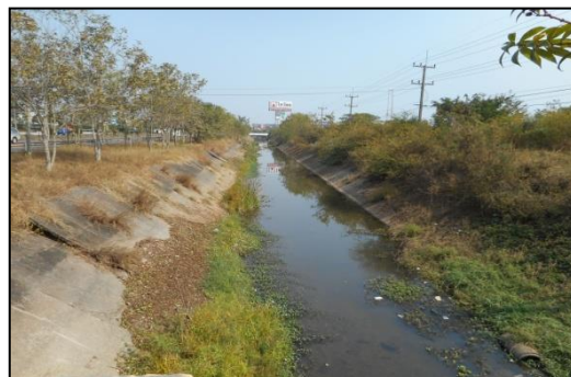
(ณ) คลองระบายน้ำข้างถนนเลี้ยวเมืองด้านตะวันออก อัตราการไหลของคลอง 70 ลบ.ม./วินาที
