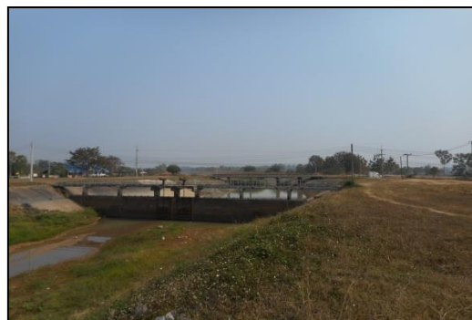
(ค) คลองระบายน้ำชุดใหม่จากอ่างฯหนองสำโรงไปลงห้วยหลวง อัตราการไหล 90 ลบ.ม./วินาที
