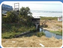
ด้านท้ายน้ำสถานีสูบน้ำท้ายห้วยมั่ง
