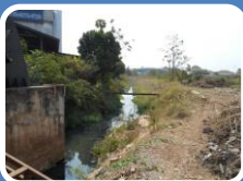
ด้านเหนือน้ำสถานีสูบน้ำท้ายห้วยมั่ง
