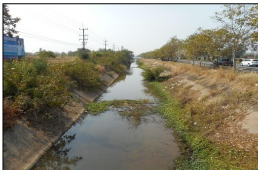
(ณ) คลองระบายน้ำข้างถนนเลี้ยวเมืองด้านตะวันออก อัตราการไหลของคลอง 70 ลบ.ม./วินาที
