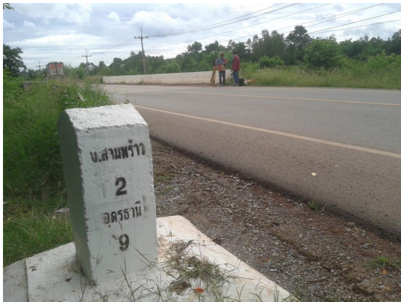
รูปที่ จ-31 การสำรวจระดับถนนถนนสาย อด.4081 ช่วง กม.1 ถึง กม.3 (อบต.สามพร้าว ถึง บ้านดอนหาด)
