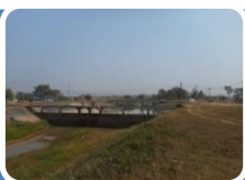
อาคารระบายน้ำหนองสำโรง
