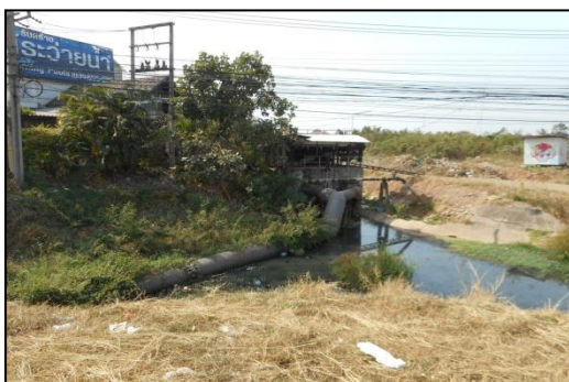
(จ) สถานีสูบน้ำท้ายห้วยม้ง (P5) อัตราการสูบน้ำ 4 ลบ.ม./วินาที จำนวน 3 เครื่อง ระบายน้ำจากห้วยม้งลงคลองระบายน้ำข้างถนนเลี่ยงเมืองไปลงห้วยหลวง
