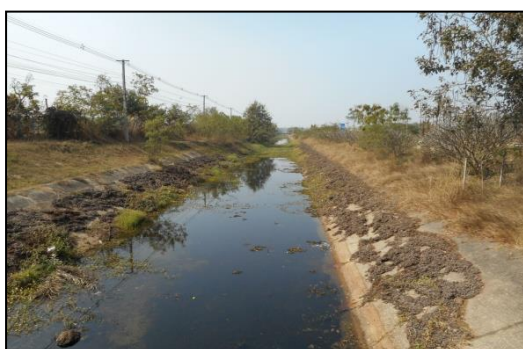
(ข) คลองระบายน้ำข้างถนนเลี้ยวเมืองด้านใต้ อัตราการไหลของคลอง 45 ลบ.ม./วินาที
