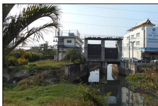
(ง) สถานีสูบน้ำท้ายลำห้วยหมากแข้ง (P3) อัตราการสูบน้ำ 12 ลบ.ม./วินาที จำนวนเครื่องสูบน้ำทั้งหมด 6 เครื่อง สูบน้ำลงคลองระบายน้ำข้างถนนเลี่ยงเมือง
