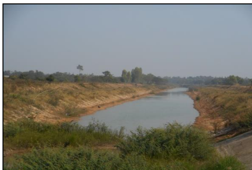
(ค) คลองระบายน้ำชุดใหม่จากอ่างฯหนองสำโรงไปลงห้วยหลวง อัตราการไหล 90 ลบ.ม./วินาที
