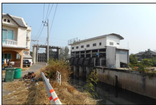
(ง) สถานีสูบน้ำท้ายลำห้วยหมากแข้ง (P3) อัตราการสูบน้ำ 12 ลบ.ม./วินาที จำนวนเครื่องสูบน้ำทั้งหมด 6 เครื่อง สูบน้ำลงคลองระบายน้ำข้างถนนเลี่ยงเมือง
