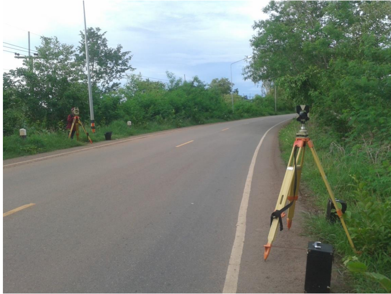
รูปที่ จ-30 การสำรวจระดับถนนถนนสาย อด.4081 ช่วง กม.1 ถึง กม.3 (อบต.สามพร้าว ถึง บ้านดอนหาด)
