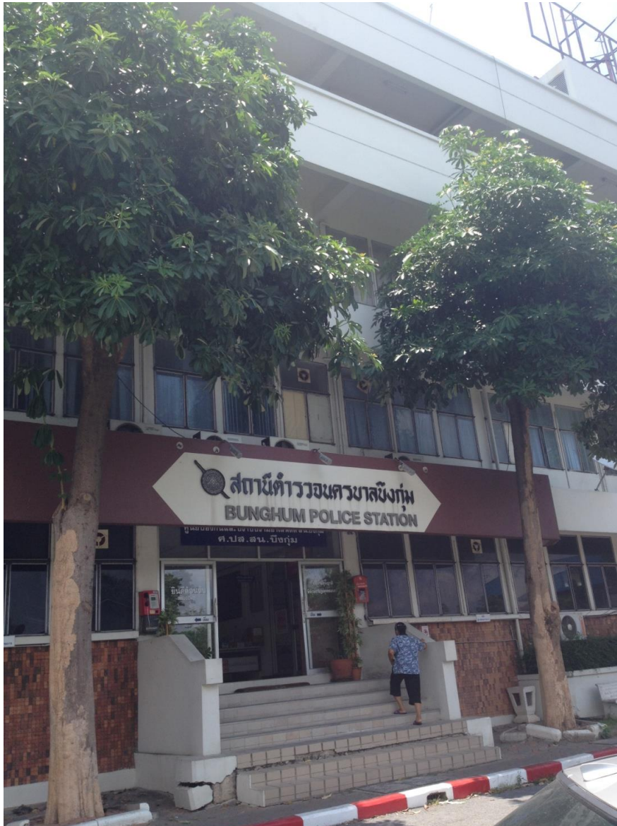
รูปที่ ข6.1 สถานีตำรวจนครบาลบึงกุ่ม
