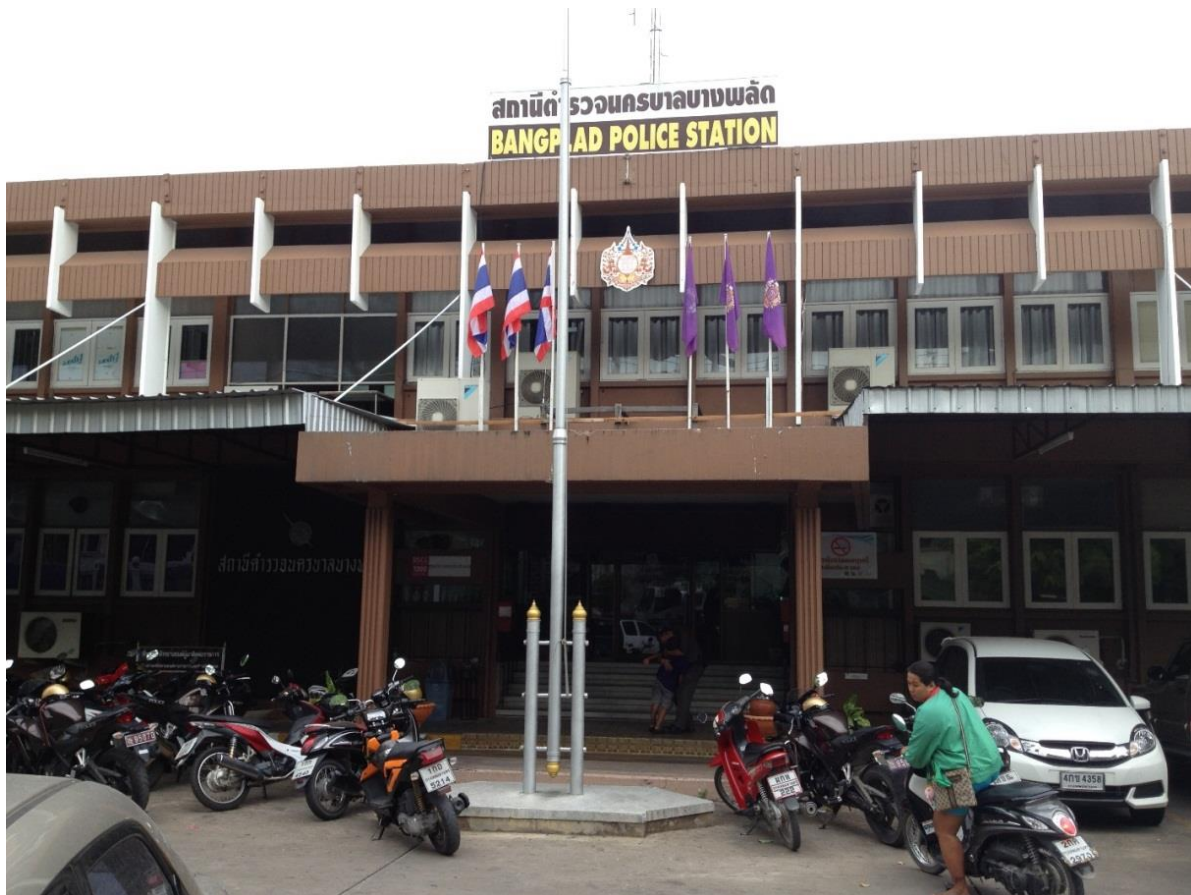
รูปที่ ข9.1 สถานีตำรวจนครบาลบางพลัด
