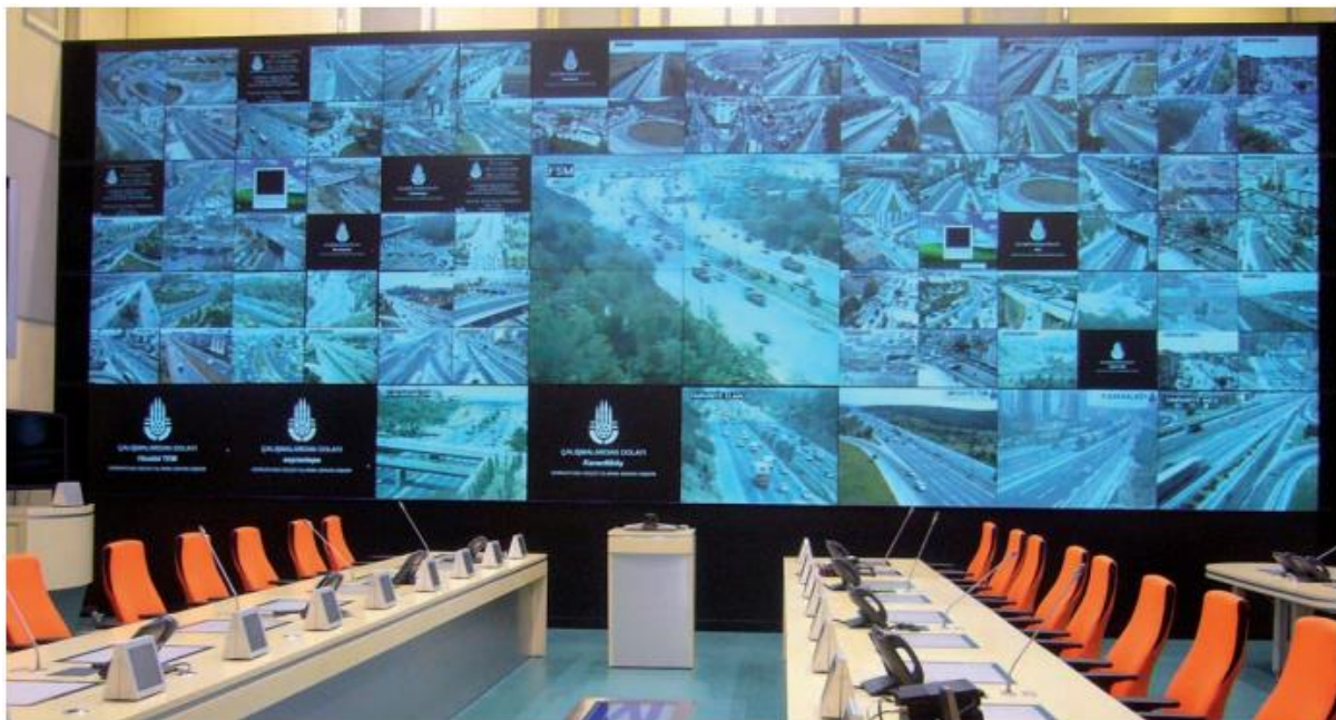
รูปที่ 2.4 ศูนย์ควบคุมการจราจรของเมืองอิสตันบูล ประเทศตุรกี ที่มา: Dijk (2010)
