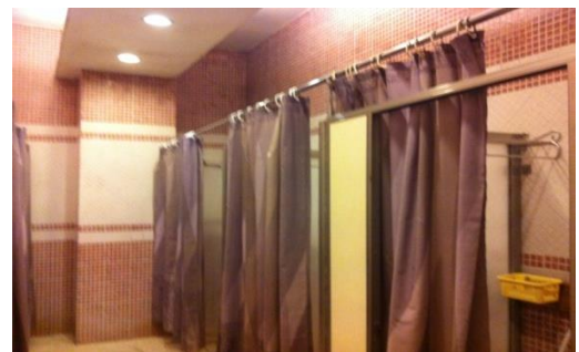
ภาพที่ 4.101 ห้องแช่ตัวของพุน้ำร้อนโคลนในโรงแรม
