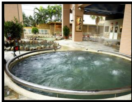
ภาพที่ 4.46 บ่อแช่รวมภายนอกอาคาร
