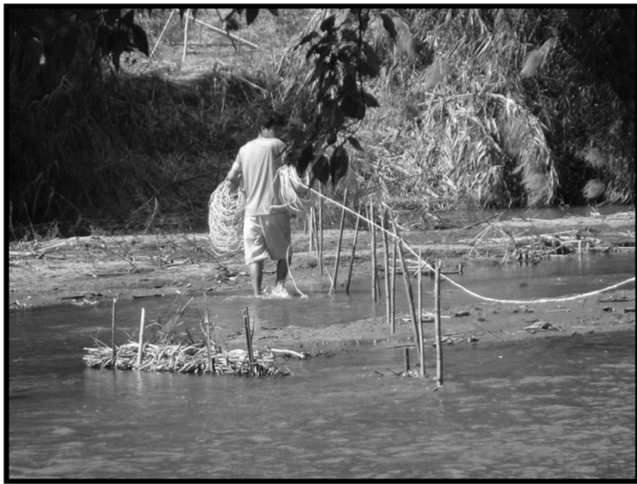
ภาพที่ 6.27 การลากสายไฟฟ้าผ่านแม่น้ำ
