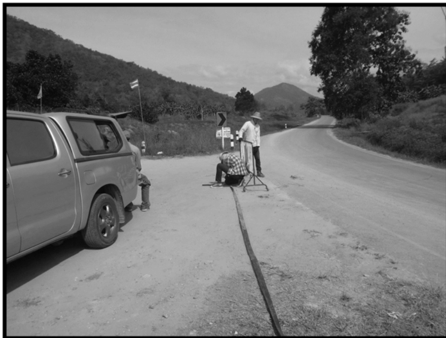
ภาพที่ 6.24 วางสายยางกันสายไฟ บริเวณลานจอดรถน้ำพุร้อน
