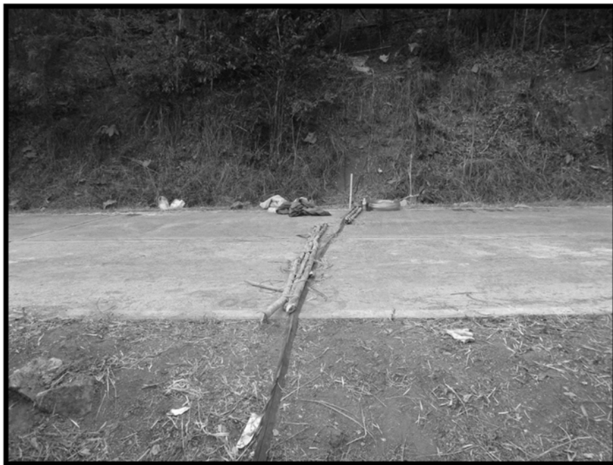
ภาพที่ 6.25 การวางสายยางกันสายไฟ ตัดผ่านถนน
