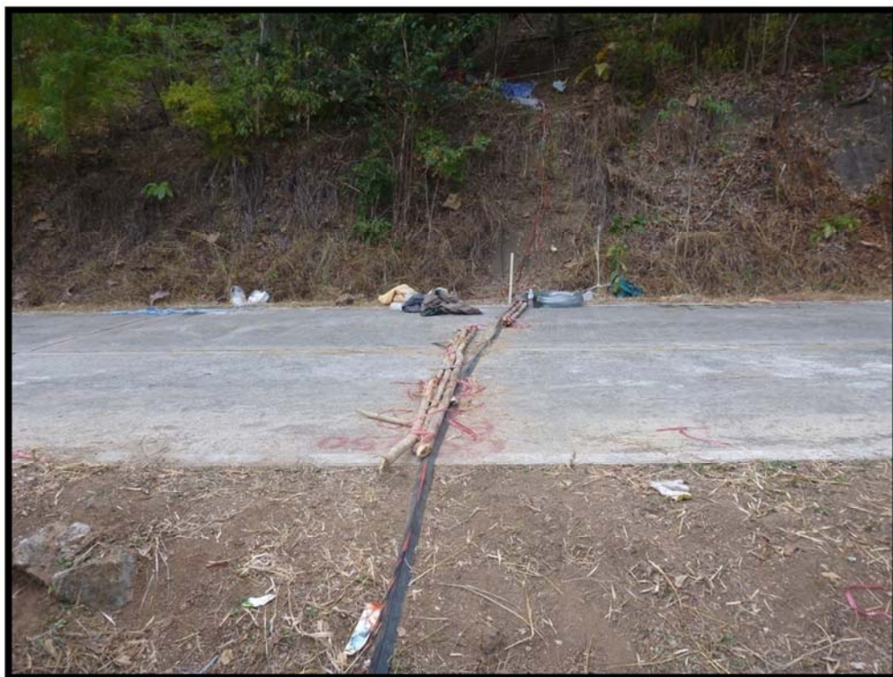
ภาพที่ 3.30 การวางแนวสำรวจที่ตัดผ่านถนน ที่ขวางแนวสำรวจอยู่
