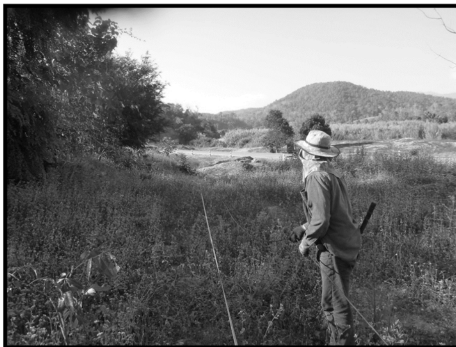
ภาพที่ 6.26 การวางสายไฟตามแนวสำรวจ
