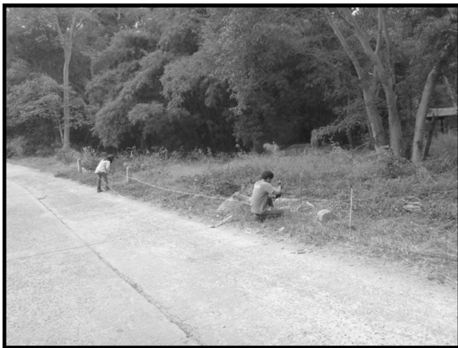
ภาพที่ 6.22 การปักไม้ไผ่ทำสัญลักษณ์ตำแหน่งแนวสำรวจ
