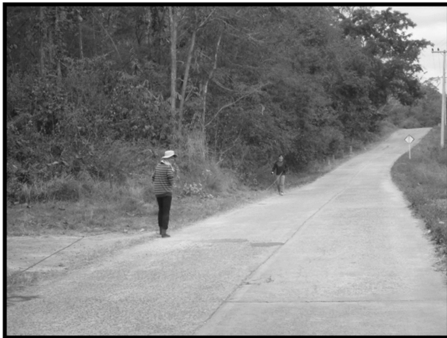
ภาพที่ 6.21 การวัดระยะทางทำแนวสำรวจ
