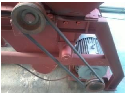
รูปที่ ข.15 การติดตั้งมอเตอร์
