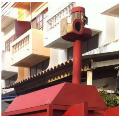
รูปที่ ข.8 การประกอบฝาถังและติดตั้งโบลเวอร์
