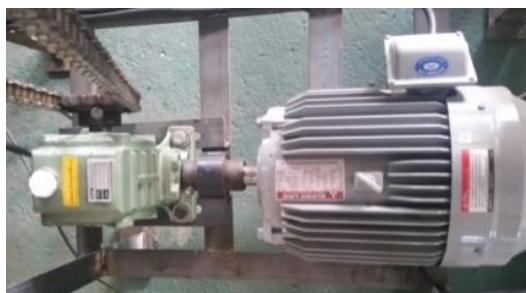
รูปที่ ข.9 ติดตั้งมอเตอร์ไฟฟ้า
