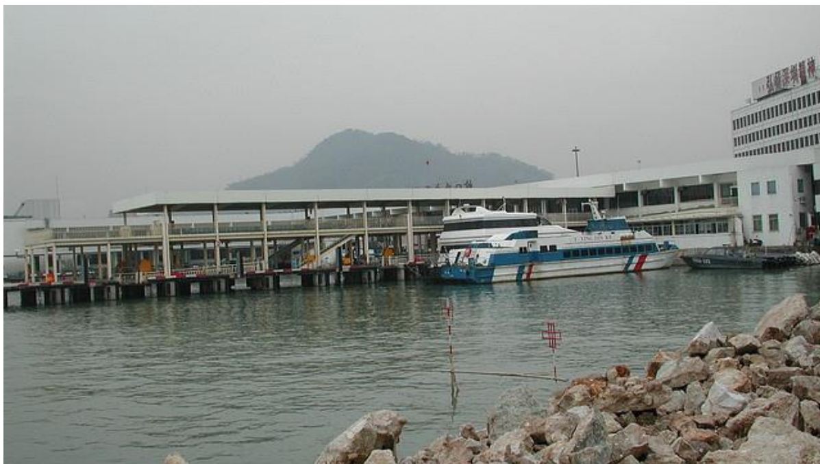
รูปที่ ค-1 ท่าเทียบเรือและอาคารผู้โดยสารเสอไห่ (Shekou Passenger Terminal)
