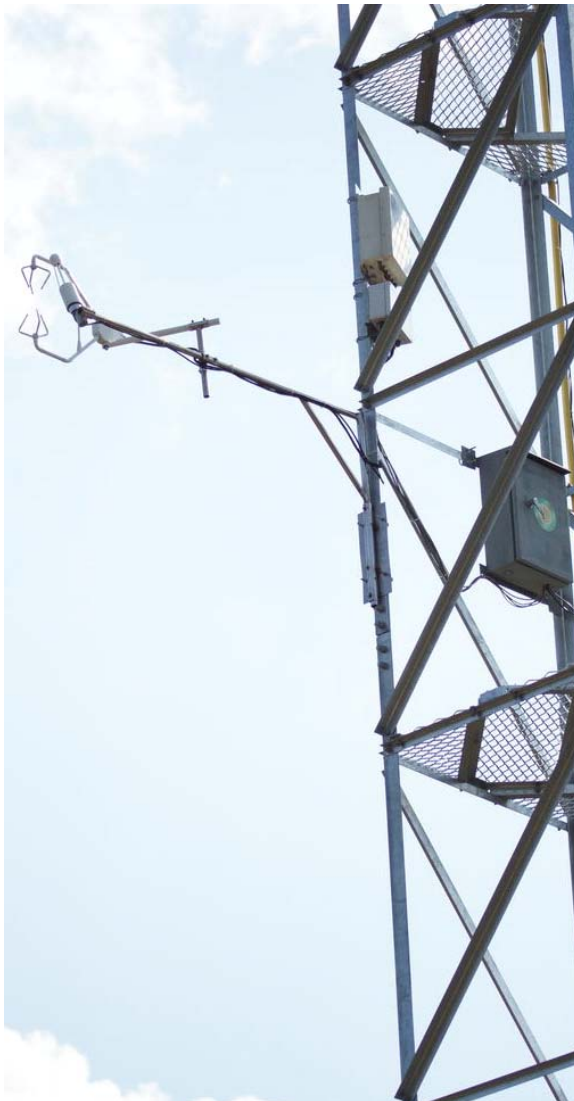
(a) ชุดอุปกรณ์ Eddy covariance ที่ติดตั้งบน tower
