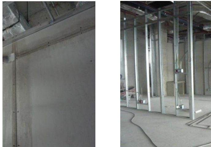
รูปที่ 3.2 การก่อสร้างผนังเบา (Dry Wall) ซึ่งโครงสร้างเป็นลักษณะ Board on Frame โดยผลิตภัณฑ์ปิดผิวที่ใช้เป็นแผ่นไฟเบอร์ซีเมนต์ ตรา สมาร์ทบอร์ด ของบริษัท SCG
