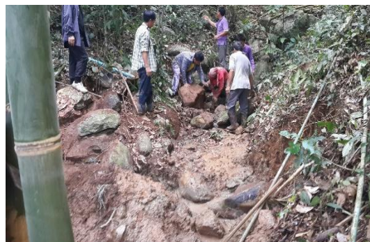
ภาพที่ 5: ใช้วัสดุที่มีอยู่ในพื้นที่โดยเลือกหินก้อนใหญ่สุดทำเป็นฐานของตัวฝายต้นน้ำ
