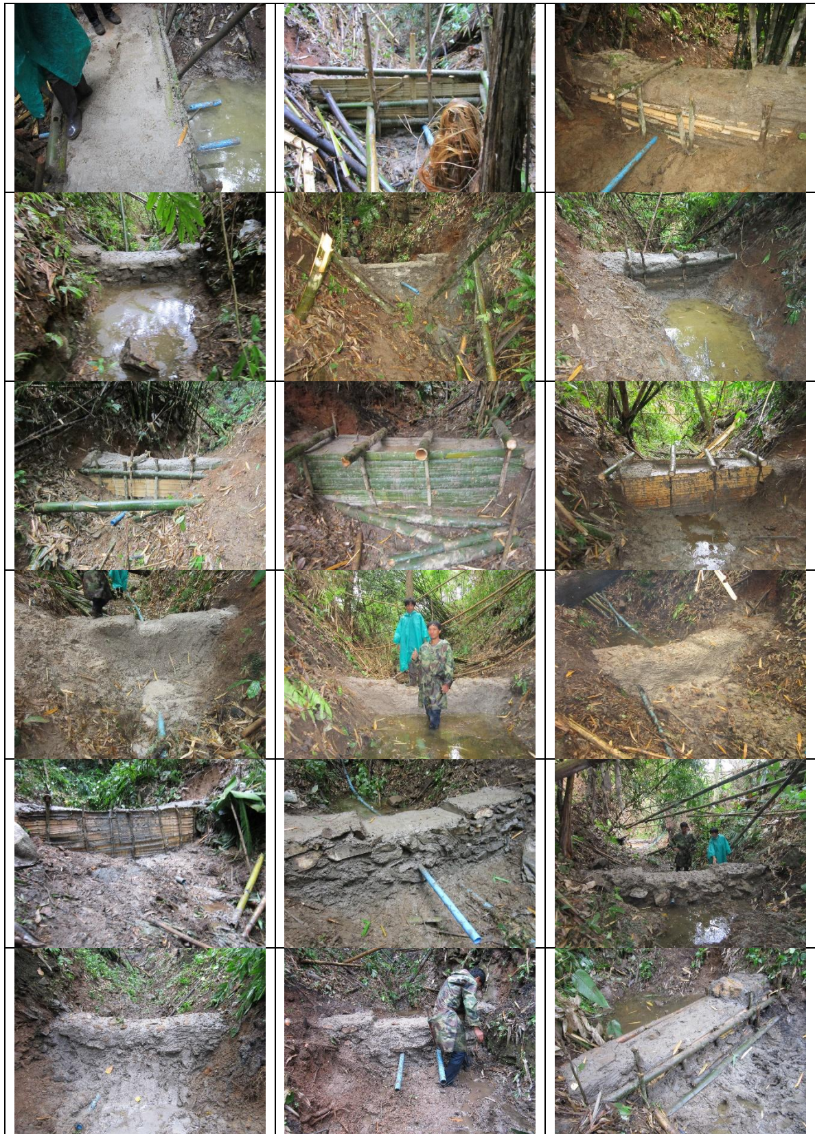
ภาพที่ 15: ผลงานการก่อสร้างฝายต้นน้ำบ้านแม่คำหล้า ทั้ง 18 จุด
