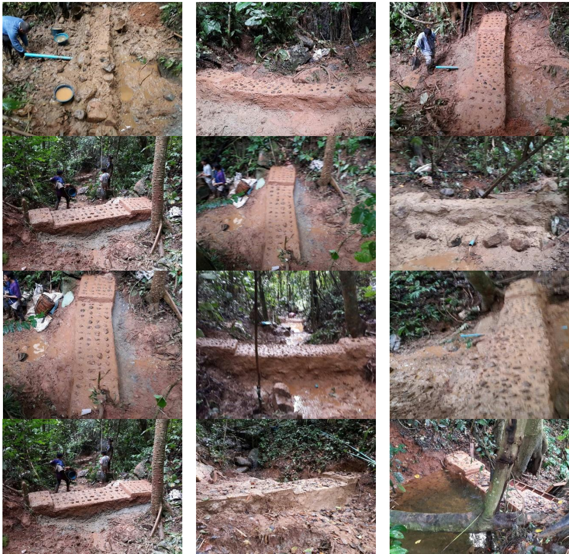
ภาพที่ 14: ผลงานการก่อสร้างฝายต้นน้ำบ้านบ่อสี่เหลี่ยมทั้ง 11 จุด
