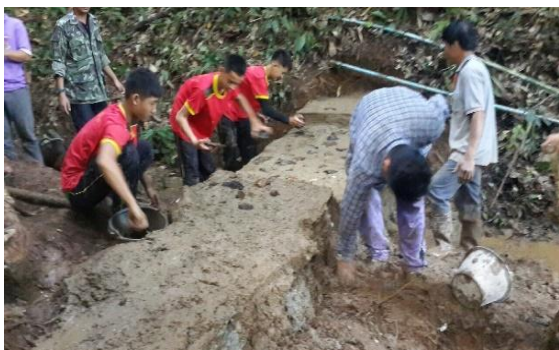
ภาพที่ 3: การสร้างฝายกั้นถาวรโดยไม่ใช้ไม้แบบ
