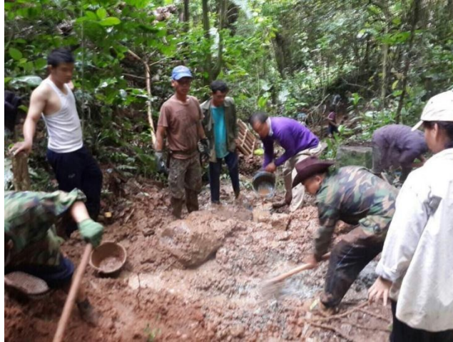
ภาพที่ 11: การผสมปูนซีเมนต์ปอร์ตแลนด์กับดินในบริเวณข้างเคียงจุดสร้างฝายต้นน้ำ
