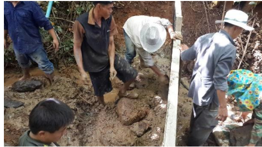
ภาพที่ 8: เรียงหินก้อนใหญ่ใช้เป็นฐานของฝายต้นน้ำแบบกึ่งถาวร
