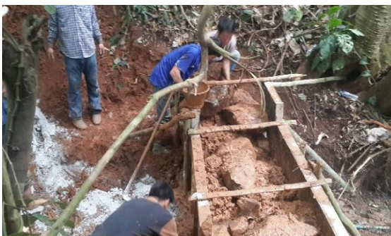
ภาพที่ 2: การสร้างฝายกึ่งถาวรที่สร้างโดยใช้ไม้แบบ
