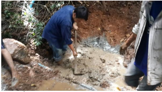
ภาพที่ 7: เทรองแกนของฝายก่อนด้วยปูนผสมแบบเหลว
