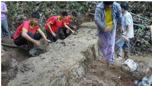
ภาพที่ 9: ปั่นปูนผสมเหนียวขึ้นเพื่อก่อและการเก็บรายละเอียดขั้นสุดท้าย
