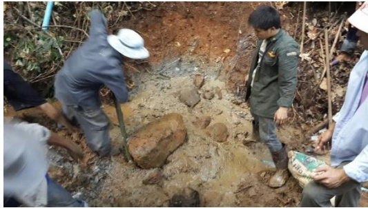
ภาพที่ 8: เรียงหินก้อนใหญ่ใช้เป็นฐานของฝายต้นน้ำแบบกึ่งถาวร
