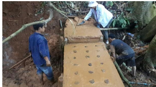
ภาพที่ 9: ปั่นปูนผสมเหนียวขึ้นเพื่อก่อและการเก็บรายละเอียดขั้นสุดท้าย
