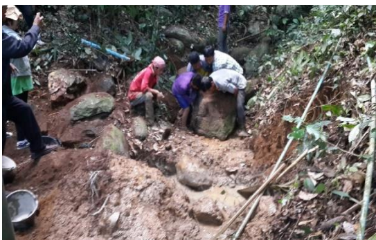
ภาพที่ 5: ใช้วัสดุที่มีอยู่ในพื้นที่โดยเลือกหินก้อนใหญ่สุดทำเป็นฐานของตัวฝายต้นน้ำ
