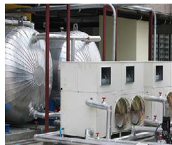
รูปที่ 8-6 อุปกรณ์ผลิตน้ำร้อน Heat Pump
