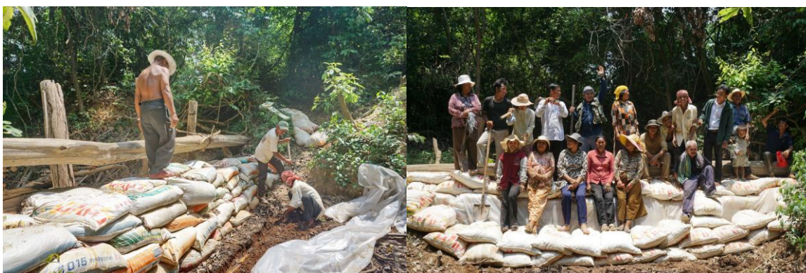
ภาพที่ 3 – 13 ปฏิบัติการทำฝายชะลอน้ำลำห้วยโอะกะกิรลือเพื่อทำกิจกรรมอินทรีย์
