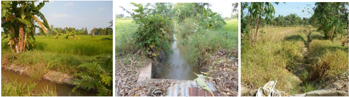
รูปที่ 4.14 สภาพคลองส่งน้ำในพื้นที่ดงบ้านอัน
