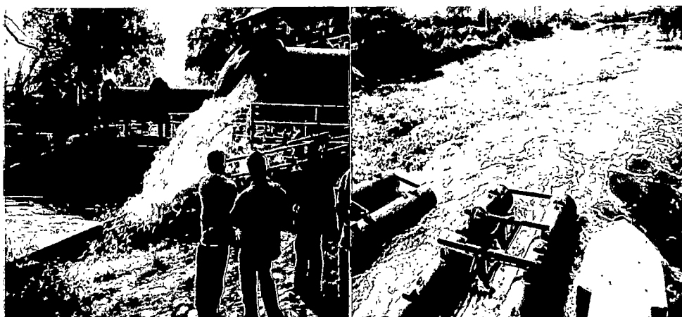
ภาพที่ 49 การระบายน้ำด้วยการใช้ท่อดูดน้ำ เพิ่มอัตราการไหลของน้ำ
