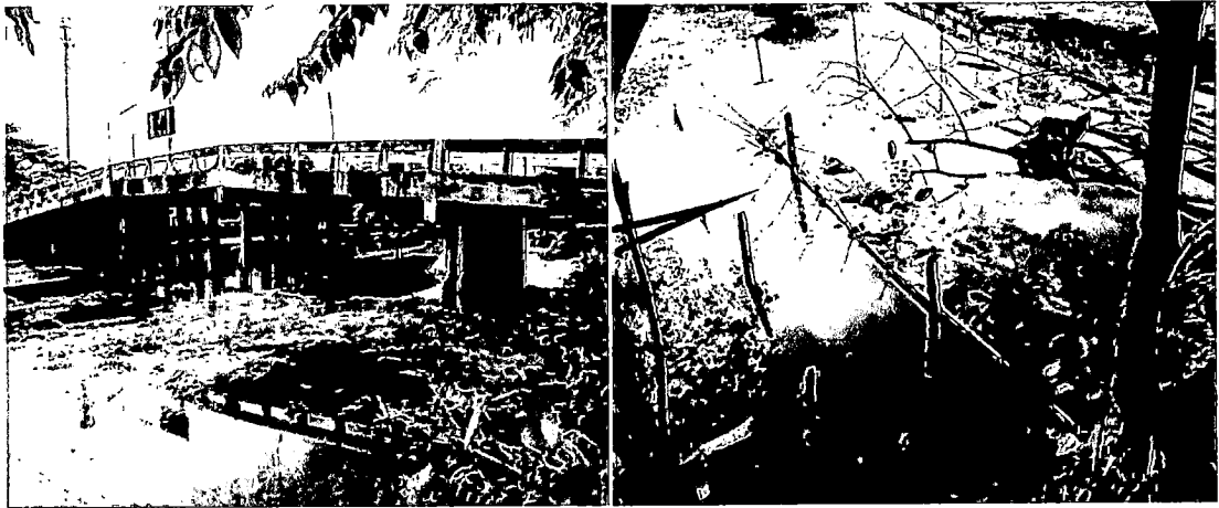
ภาพที่ 30 การสร้างสะพานที่มีเสาตอม่อ และเศษกิ่งไม้ติด
