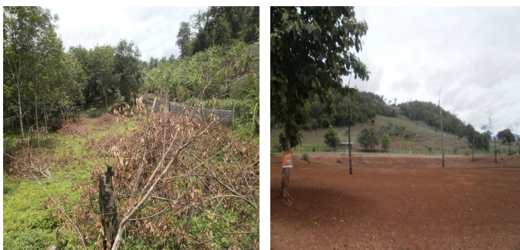
ภาพที่ 53-54 ปรับปรุงพื้นที่เพื่อทำเป็นสถานที่ก่อสร้างให้เป็นตลาดรับซื้อผลผลิตยางพาราของกลุ่มเกษตรกรจำหน่ายผลผลิตที่เหมาะสมกับการทำตลาดท้องถิ่นในบริเวณตำบลเมืองนะ มีจำนวน 3 ไร่ 50 ตารางวา ซึ่งอยู่ในการดำเนินการดำเนินงาน
