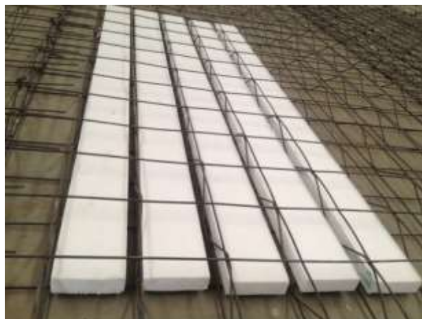
รูปที่ 2.2-9 การใส่แผ่นโฟมในโครงเหล็กเพื่อลดน้ำหนักคอนกรีตที่เท
