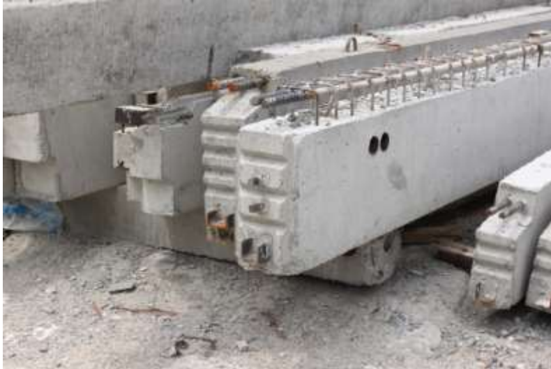
รูปที่ 1.6-8 รอยบากที่ปลายคานเพื่อช่วยการยึดเกาะกับปูนปิดทับรอยต่อ
