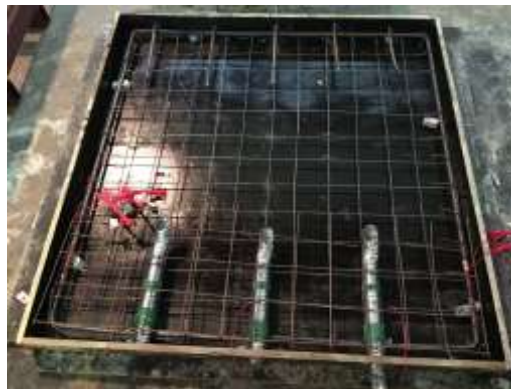
รูปที่ 2.3-6 แสดงการฝังท่อ Corrugate duct ในผนังตัวอย่าง GR
