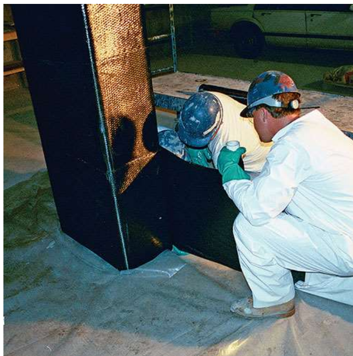
รูปที่ 3.1-6 การเสริมกำลังด้วยแผ่นโพลีเมอร์เสริมเส้นใย
