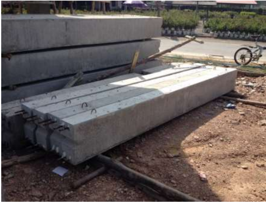
รูปที่ 1.2-17 ชิ้นส่วนคานคอนกรีตเสริมเหล็กสำเร็จรูปในงานก่อสร้างอาคารพาณิชย์ในประเทศไทย
