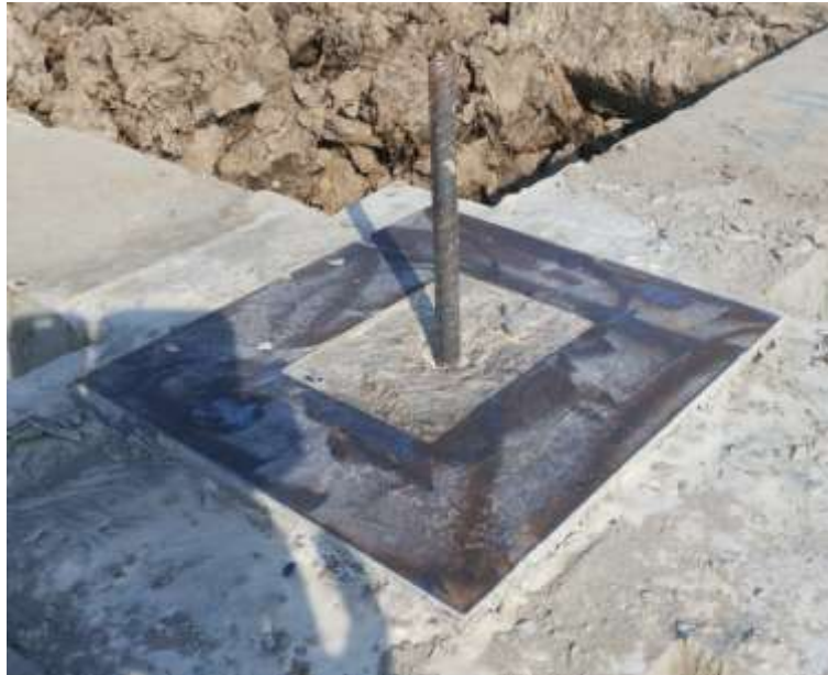
รูปที่ 1.5-9 จุดรองรับเสาที่ติดตั้งด้วยการเชื่อมแผ่นเหล็กและเหล็กกำกับแนว (อ้างอิงจากบริษัท เอส เค คอนกรีต โปรดักส์ จำกัด)
