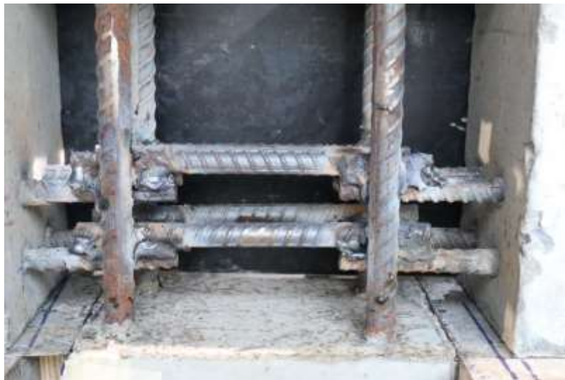
รูปที่ 1.7-23 การเชื่อมต่อเหล็กเสริมคานแต้ฝัของจุดต่อด้วยระยะทาบที่เพียงพอ (PS-1)
