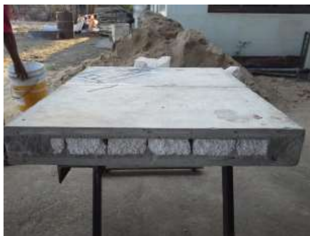
รูปที่ 2.2-10 หน้าตัดผนังสำเร็จรูปที่มีโฟมอยู่ด้านใน
