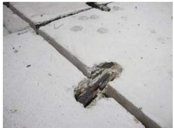
รูปที่ 2.2-13 การยึดระหว่างแผ่นด้วยเหล็กเดือยและทำการเชื่อม
