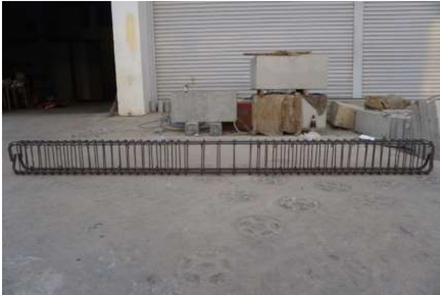
รูปที่ 3.1-73 การเตรียมโครงเหล็ก
