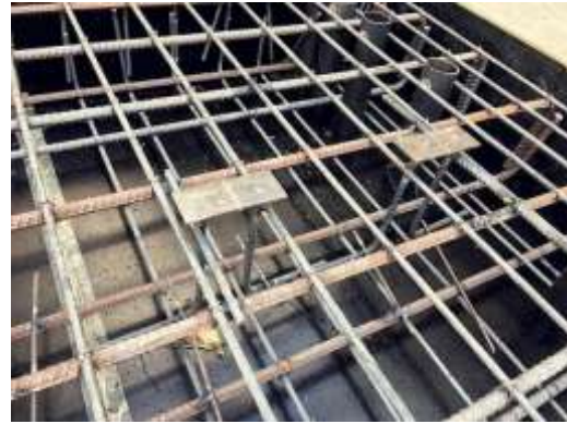
รูปที่ 2.3-5 รายละเอียดทั่วไปของทั่วไปของจุดต่อแบบ WA (ก) แสดงการฝังแผ่นเหล็กฝังในผนังกำแพง (ข) แสดงการฝังแผ่นเหล็กในฐานราก
