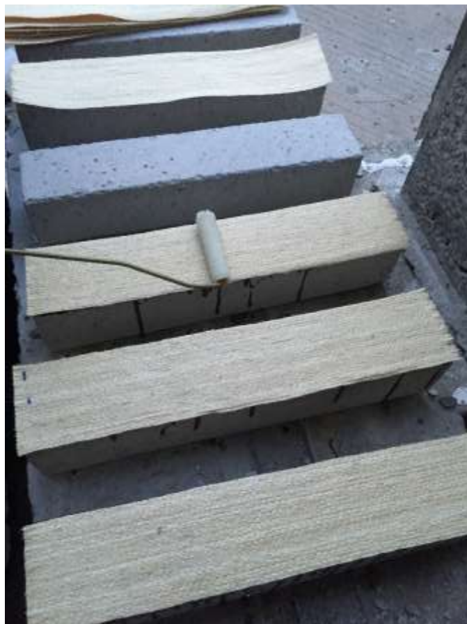
รูปที่ 3.1-65 การติดตั้งเส้นใยป่านศรนารายณ์
