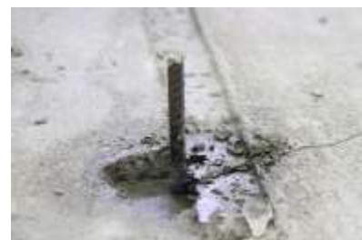
รูปที่ 2.3-4 รายละเอียดทั่วไปของทั่วไปของจุดต่อแบบ WR (ก) แสดงเหล็กเสริมของรอยต่อที่ฝังในกำแพง (ข) แสดงเหล็กเสริมโผล่ออกมาจากฐานราก
