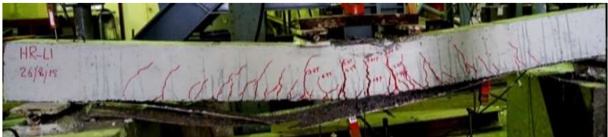
รูปที่ 3.1-90 การวิบัติของคาน HR-1LA
