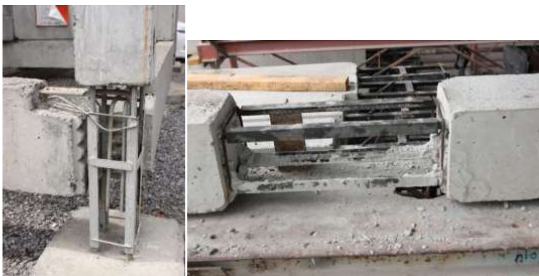
รูปที่ 1.6-7 การติดตั้งเสาหล่อสำเร็จด้วยการเชื่อมต่อเหล็กเสริมเสาเข้ากับโครงเหล็กฉาก
