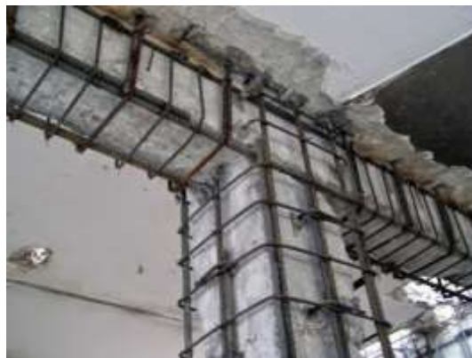
รูปที่ 3.1-3 การเสริมกำลังด้วยคอนกรีตหุ้ม
