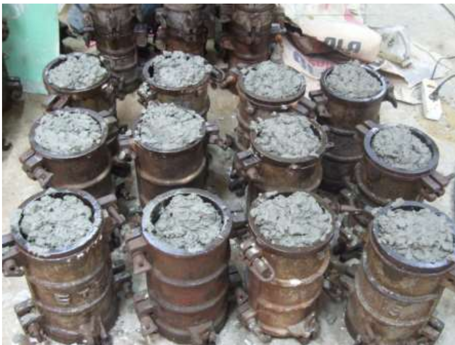
รูปที่ 3.1-37 การเทคอนกรีตในแบบหล่อเสาคอนกรีตหน้าตัดกลมขนาดเล็ก
