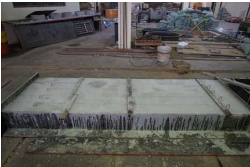
รูปที่ 3.1-74 การหล่อคานคอนกรีต
