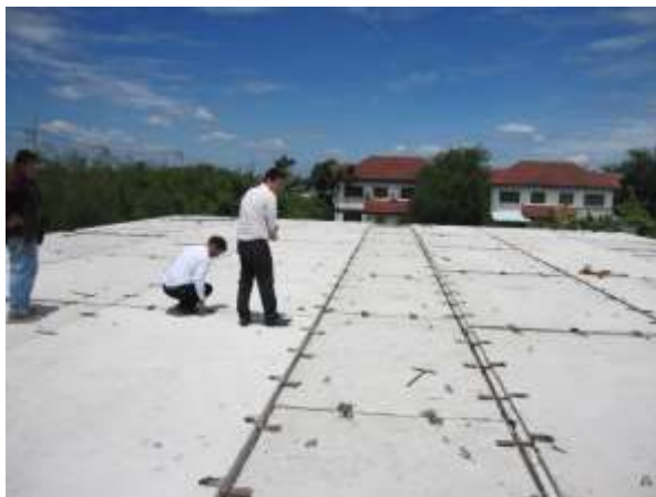
รูปที่ 2.2-13 การยึดระหว่างแผ่นด้วยเหล็กเดือยและทำการเชื่อม
