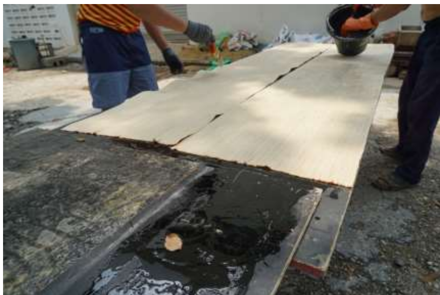
รูปที่ 3.1-76 การทำอีพอกซีเรซินลงบนแผ่นเส้นใย
