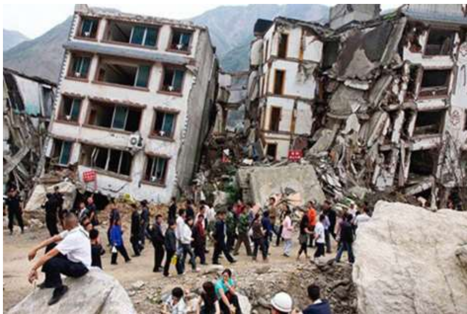
รูปที่ 3.1-1 การพังทลายของอาคารเนื่องจากแผ่นดินไหว
