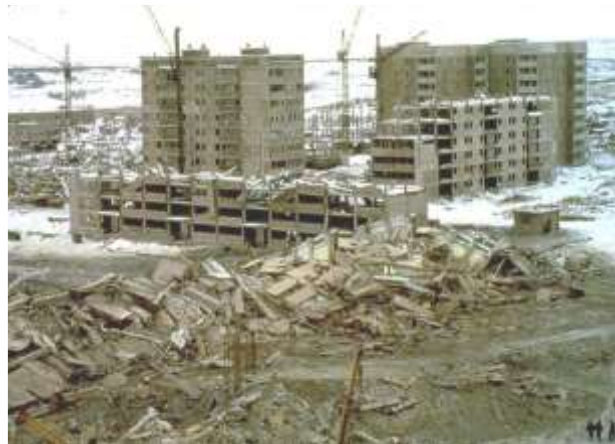
รูปที่ 2.1-2 เปรียบเทียบความเสียหายระหว่างระบบ PC Frame และ PC Wall จากเหตุการณ์ Armenia Earthquake
