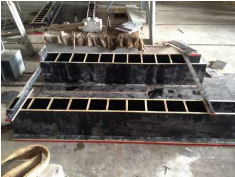
รูปที่ 3.1-39 การเตรียมแบบหล่อเสาคอนกรีตหน้าตัดสี่เหลี่ยมขนาดเล็ก
