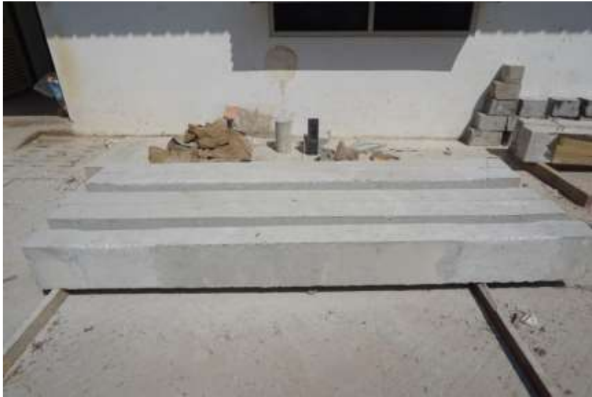
รูปที่ 3.1-75 คานคอนกรีตเสริมเหล็กที่หล่อเสร็จแล้ว
