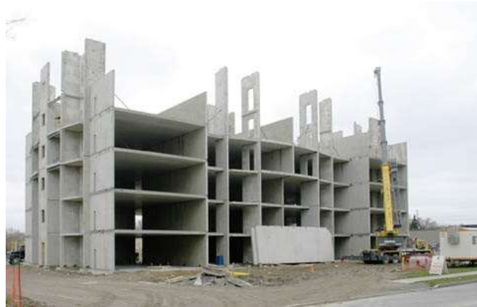
รูปที่ 2.2-4 ตัวอย่างการก่อสร้างโครงสร้างในระบบผนังรับแรง (ที่มา บริษัทเอกชนแห่งหนึ่งในประเทศไทย)
