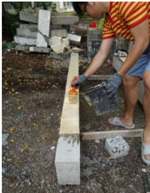
รูปที่ 3.1-78 การติดตั้งแผ่นเส้นใยธรรมชาติบนผิวคาน
