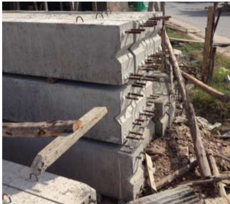
รูปที่ 1.2-18 บริเวณปลายคานคอนกรีตสำเร็จรูปที่จะเชื่อมต่อกับเสาคอนกรีตเสริมเหล็ก
