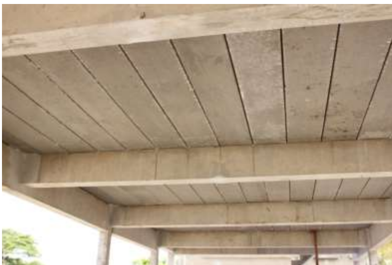
รูปที่ 1.6-5 ตัวอย่างการติดตั้งคานคอนกรีตสำเร็จรูปที่แล้วเสร็จ
