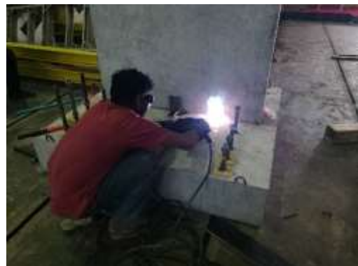
(ง) การติดตั้งผนังเข้ากับฐานราก
