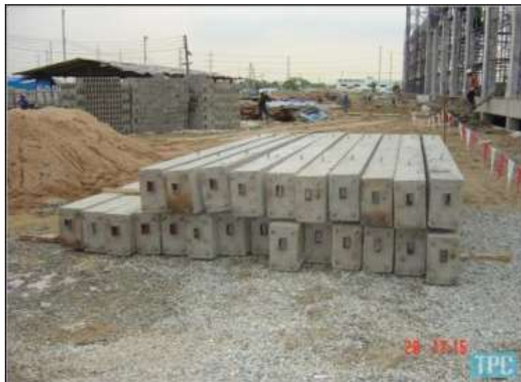
รูปที่ 1.5-16 คานคอนกรีตสำเร็จรูปแบบที่ใช้เหล็กกล่องเป็นชิ้นส่วนรองรับน้ำหนักชั่วคราว (อ้างอิงจากบริษัท ทีซี คอนกรีตอัดแรง จำกัด)
