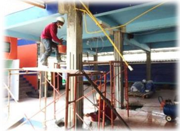
ทาน้ำยาเชื่อมประสานคอนกรีต
