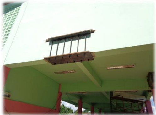
ติดตั้งน๊อตและแผ่นเหล็กแล้วเสร็จ
