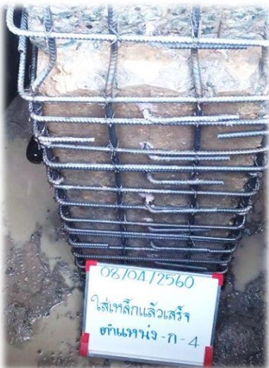
เสียบเหล็ก Shear Key แล้วเสร็จ
