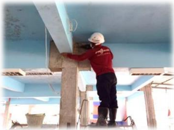
เจาะคานรับพื้นชั้น 2 เพื่อเสียบยึดเหล็กเสริม
