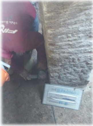
เจาะหลังฐานรากเพื่อเสียบยึดเหล็กเสริม
