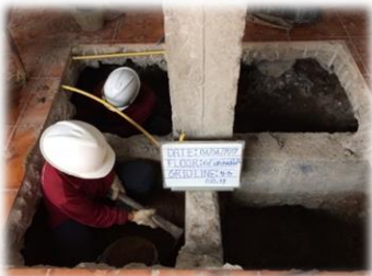
ขุดดินจนถึงระดับหลังฐานราก
