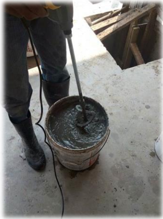
ผสม Non Shrink Concrete เพื่อเทพอกคาน
