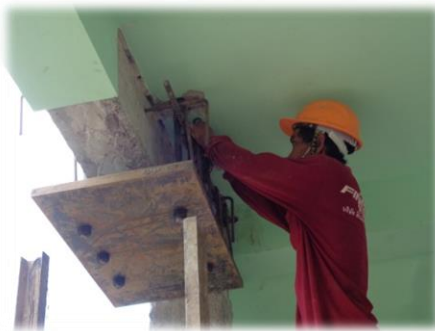
เจาะเสียบเหล็ก Shear Key
