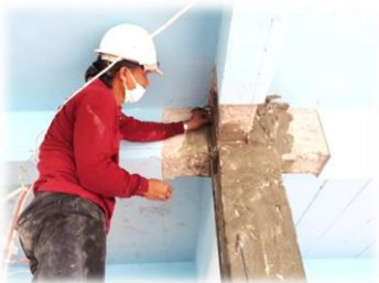
เสียบยึดเหล็กเริ่มเข้ากับคานรับพื้นชั้น 2
