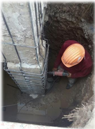
เจาะเสียบเหล็ก Shear Key
