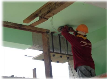
เจาะคานรับพื้นชั้น 2
