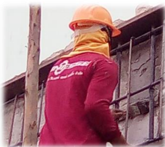
ทาน้ำยาเชื่อมประสานคอนกรีต
