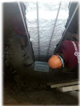
เสียบยึดเหล็กเสริมเข้ากับฐานรากแล้วเสร็จ
