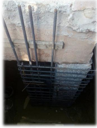
เสริมเหล็กปลอกแล้วเสร็จ
