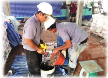
ผสม Non Shrink Concrete เพื่อเทพอกเสา
