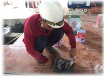
ผสมน้ำยาเคมีเพื่อเสียบยึดเหล็กเข้ากับคาน
