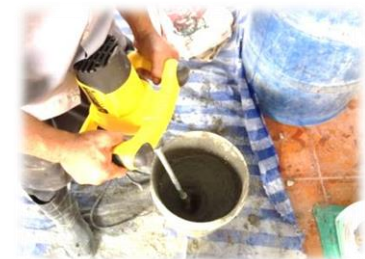
ผสม Non Shrink Concrete เพื่อเทพอกเสา
