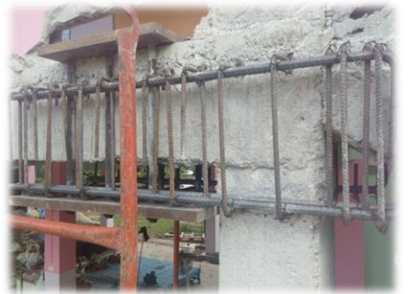
เสียบเหล็ก Shear Key แล้วเสร็จ
