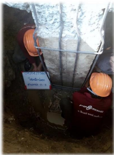
จัดเรียงเหล็กเสริมและเสริมเหล็กปลอก
