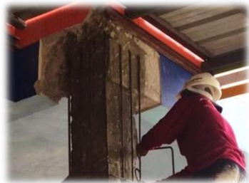
เสียบยึดเหล็กเสริมเข้ากับคานแล้วเสร็จ
