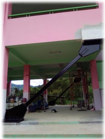
ติดตั้ง BRB แล้วเสร็จ
