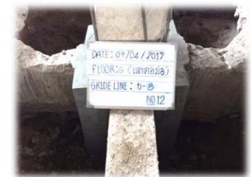
เทพอกเสาตอม่อแล้วเสร็จ
