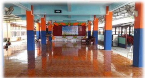
ภาพอาคารหลังการพอกเสาด้วยคอนกรีต
