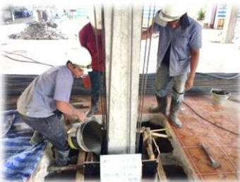
ขณะเทคอนกรีต
