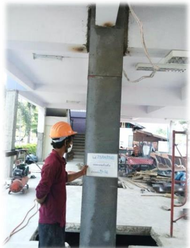
เทพอกเสาชั้น 1 แล้วเสร็จ
