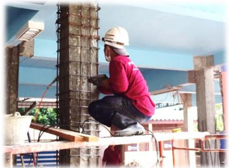
เจาะเสียบเหล็ก Shear Key
