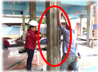
รอยต่อทาบเหล็กเสริมช่วงกลางเสาชั้น 1
