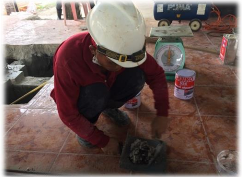
ผสมน้ำยาเคมีเพื่อเสียบยึดเหล็กเข้ากับฐานราก
