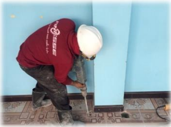
เจาะพื้นชั้น 2 เพื่อเทคอนกรีต
