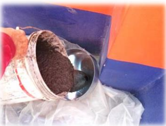
ขณะเทคอนกรีต
