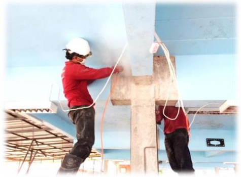
สกัดผิวปูนฉาบหุ้มคานตำแหน่งที่เสริมโครงสร้าง
