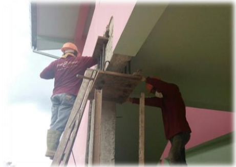
เสียบเหล็กปลอกด้วยวัสดุเชื่อมประสาน
