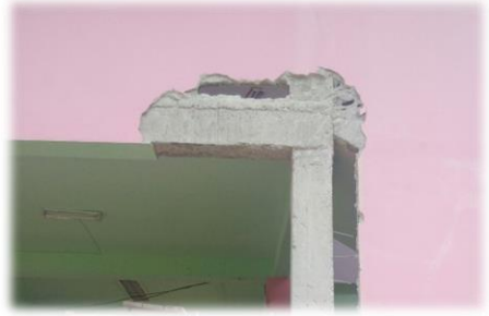
สกัดผิวปูนฉาบหุ้มคานรับพื้นชั้น 2 แล้วเสร็จ
