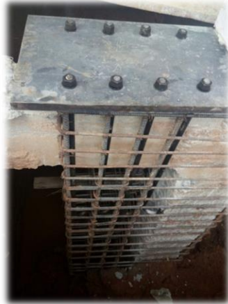
เสริมน๊อตและแผ่นเหล็กลงในเหล็กเสริมเสาตอม่อ
