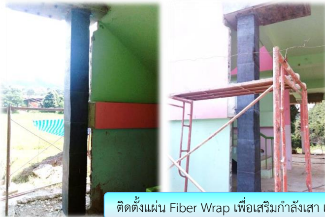
ขณะติดตั้งแผ่น Fiber Wrap เพื่อเสริมกำลังเสา
