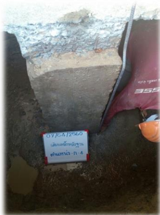
เสียบยึดเหล็กเสริมเข้ากับฐานราก
