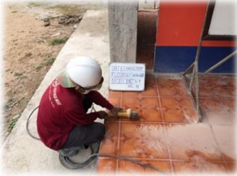
ใช้ไฟเบอร์ตัดทำแนวขอบพื้นที่จะสกัดออก
