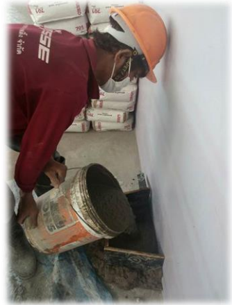
ขณะเทคอนกรีต
