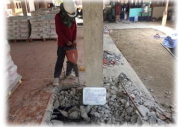
สกัดพื้นชั้น 1 เพื่อเสริมกำลังเสาตอม่อ
