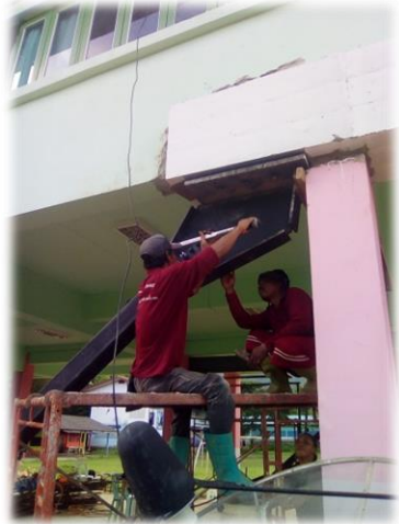
ขณะติดตั้ง BRB
