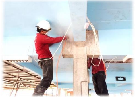
สกัดผิวปูนฉาบหุ้มคานตำแหน่งที่เสริมโครงสร้าง
