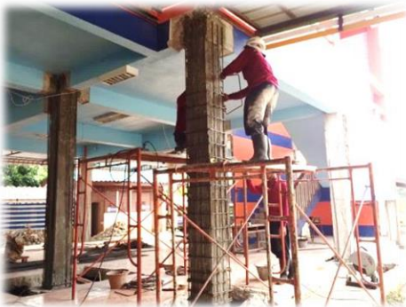
จัดเรียงเหล็กเสริมและเสริมเหล็กปลอก
